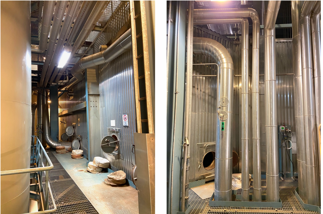
KUVA 16. JUP-putkilinja vaakasuorassa ja toinen läpivienti korkeudessa +28,2 m
