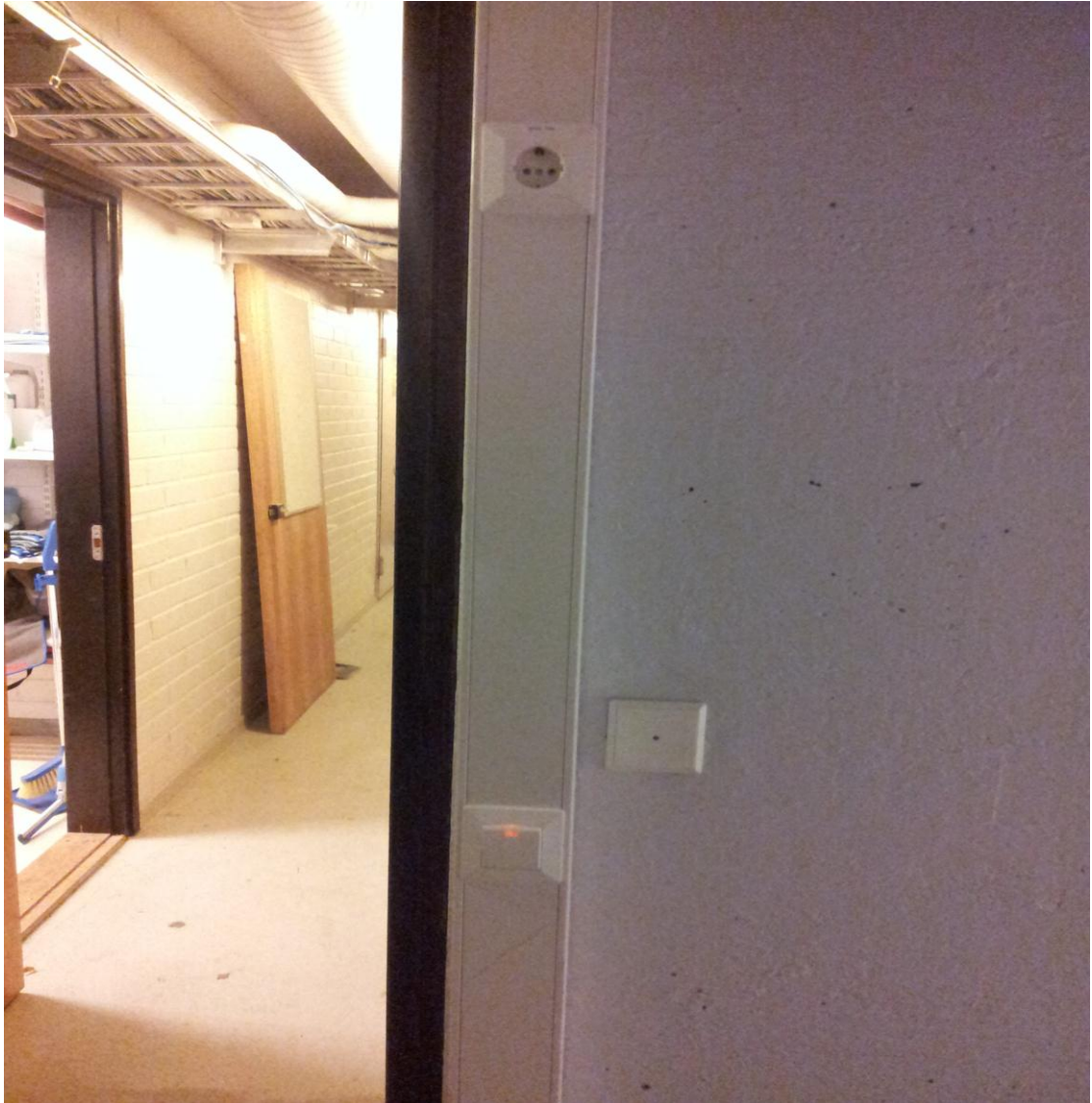
Kuvio 3. Osittainen kuva johtokanavakourusta
