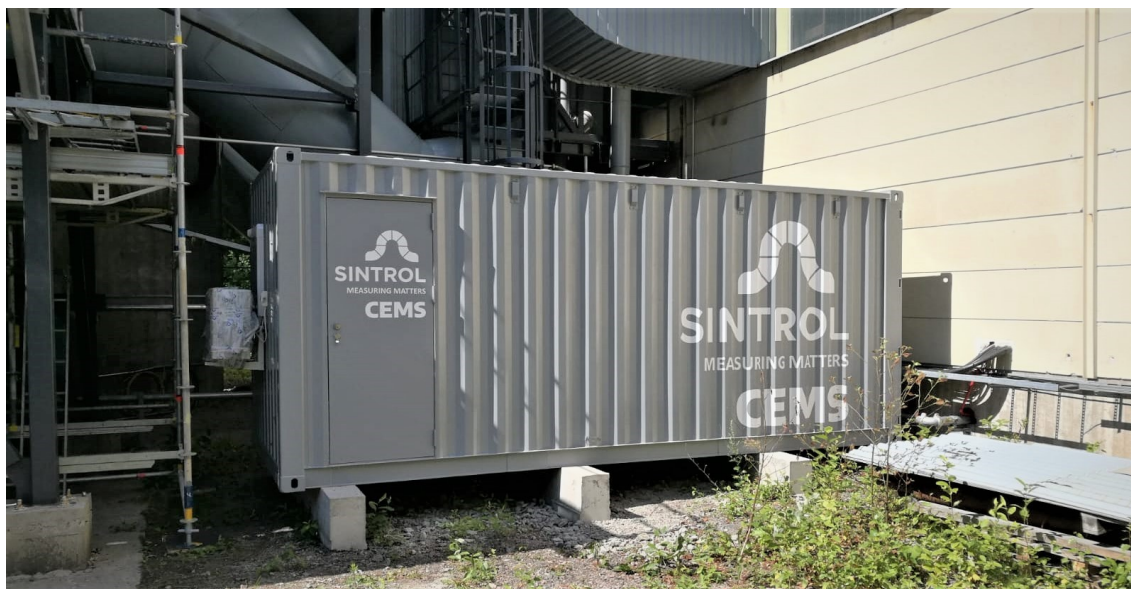
Kuva 15. Päästömittauskontti asennettuna voimalaitokselle.
