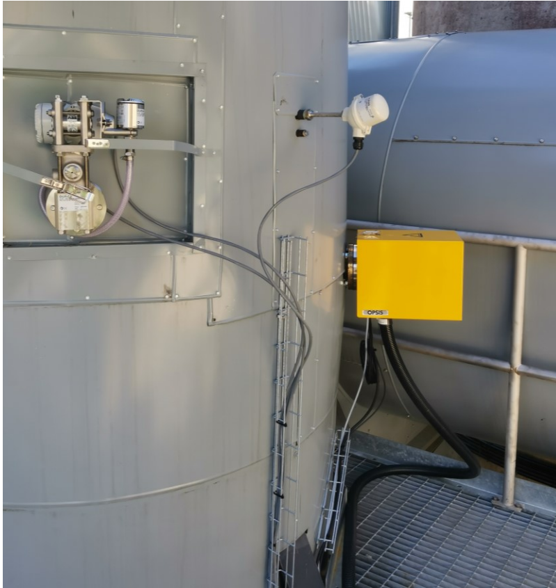
Kuva 1. Virtausmittari, lämpötila-anturi sekä Opsiksen sondi ja näytelinja.
