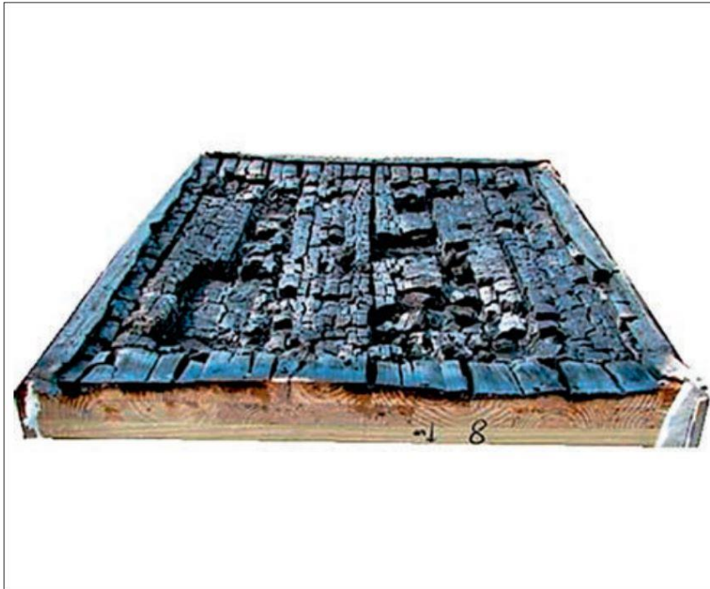
Kuva 7. Delaminoitunut CLT (Paloturvallinen puutalo 2021, 83)
