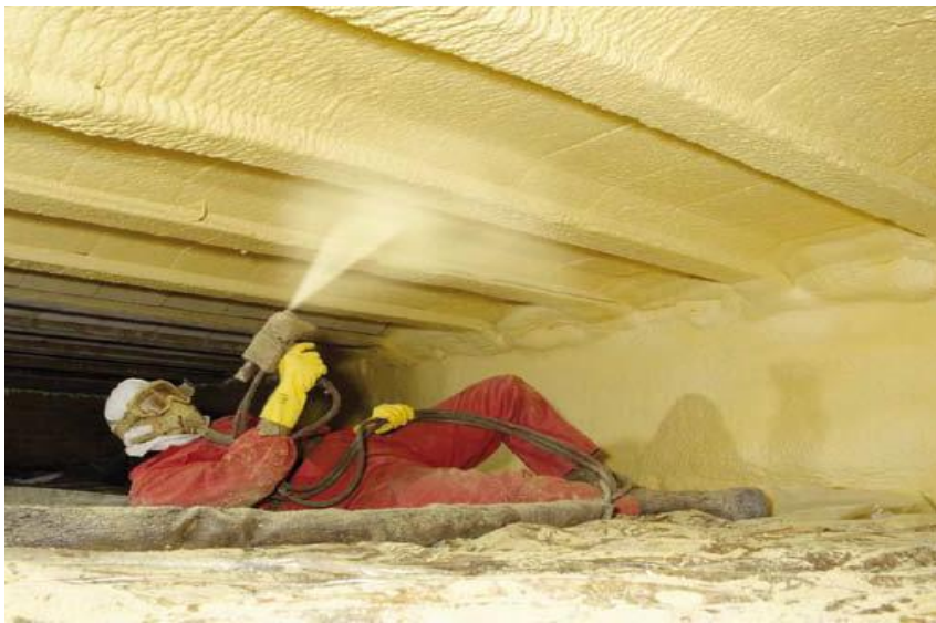
KUVA 1. Polyuretaanin ruiskutusta eristykseksi
