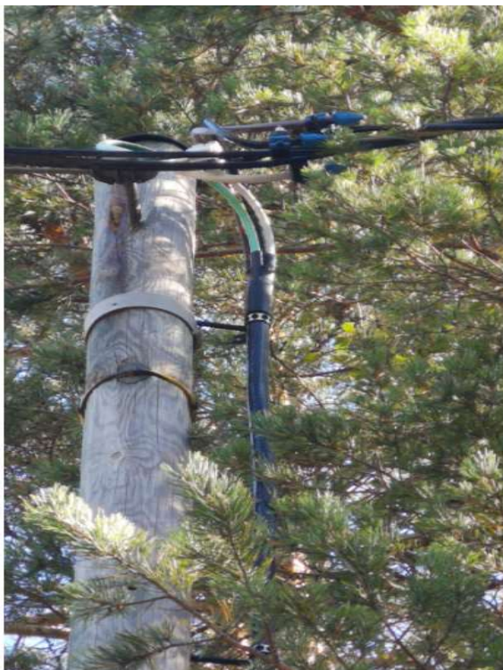
Kuva 14. Maakaapeli liitettynä ilmajohtoon jänniteliittimellä. (29.)
