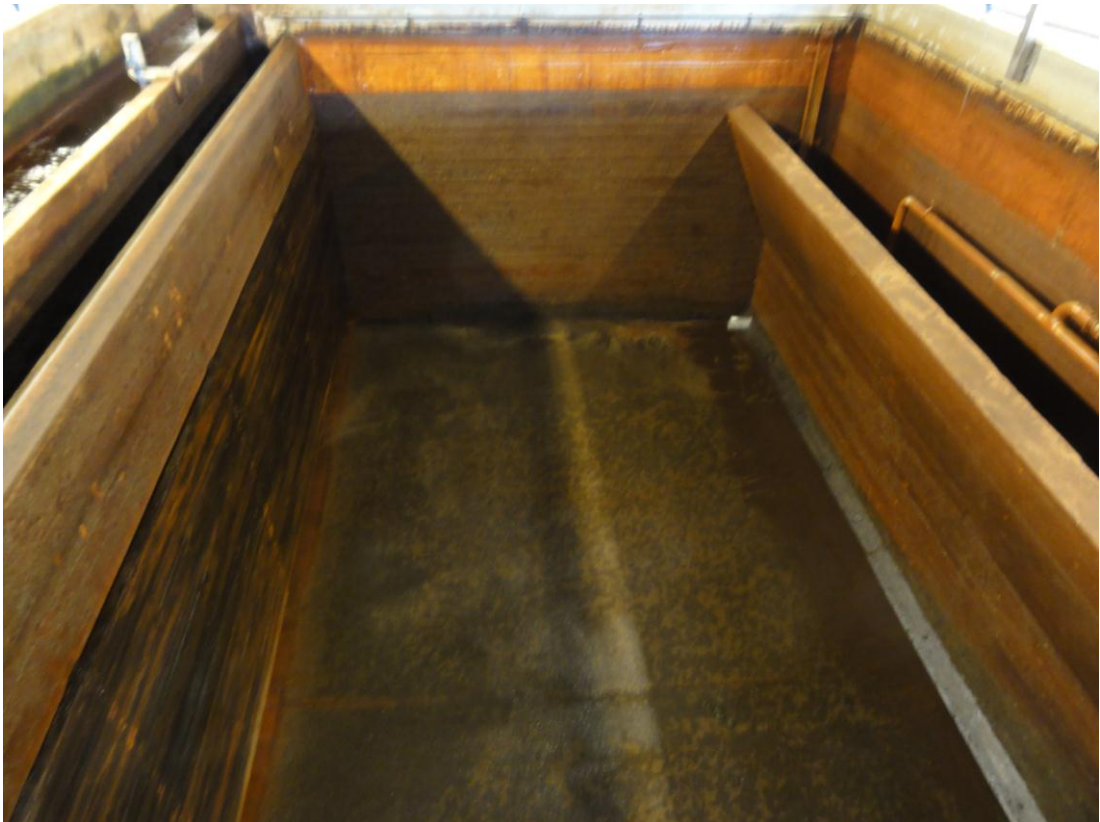
KUVA 8. Tyhjä flotaatioallas Hintan vedenpuhdistamolla
