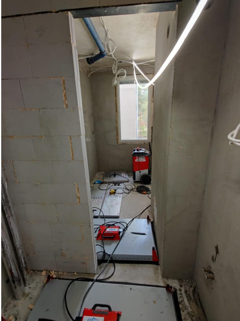
Kuva 19. Kuivatustyö tasokuivaimilla ja kosteudenpoistajalla.
