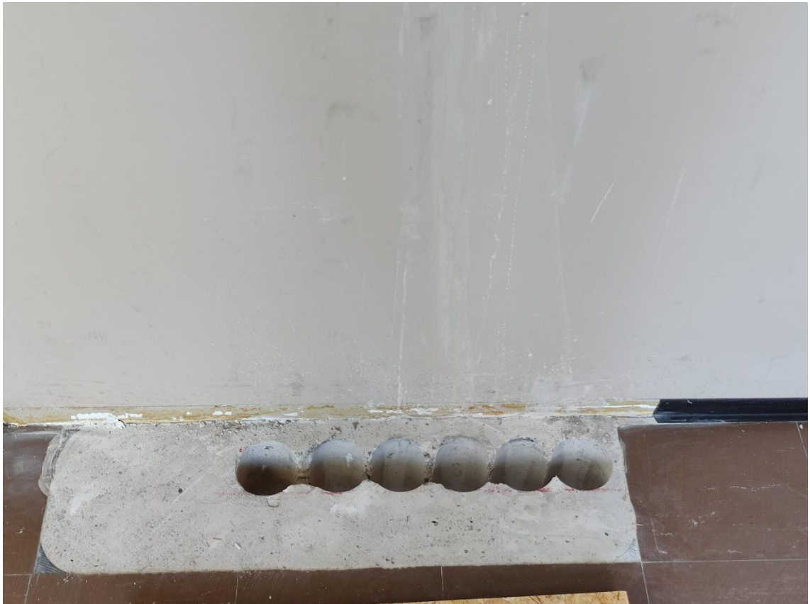
Kuva 13. Timanttiporalla porattuja reikiä kohteen porrashuoneessa.
