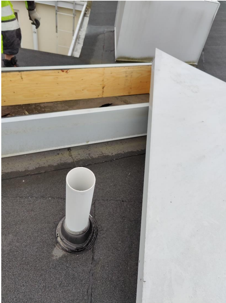
Kuva 17. Olemassa oleva tuuletusviemärin läpivienti vesikatossa.
