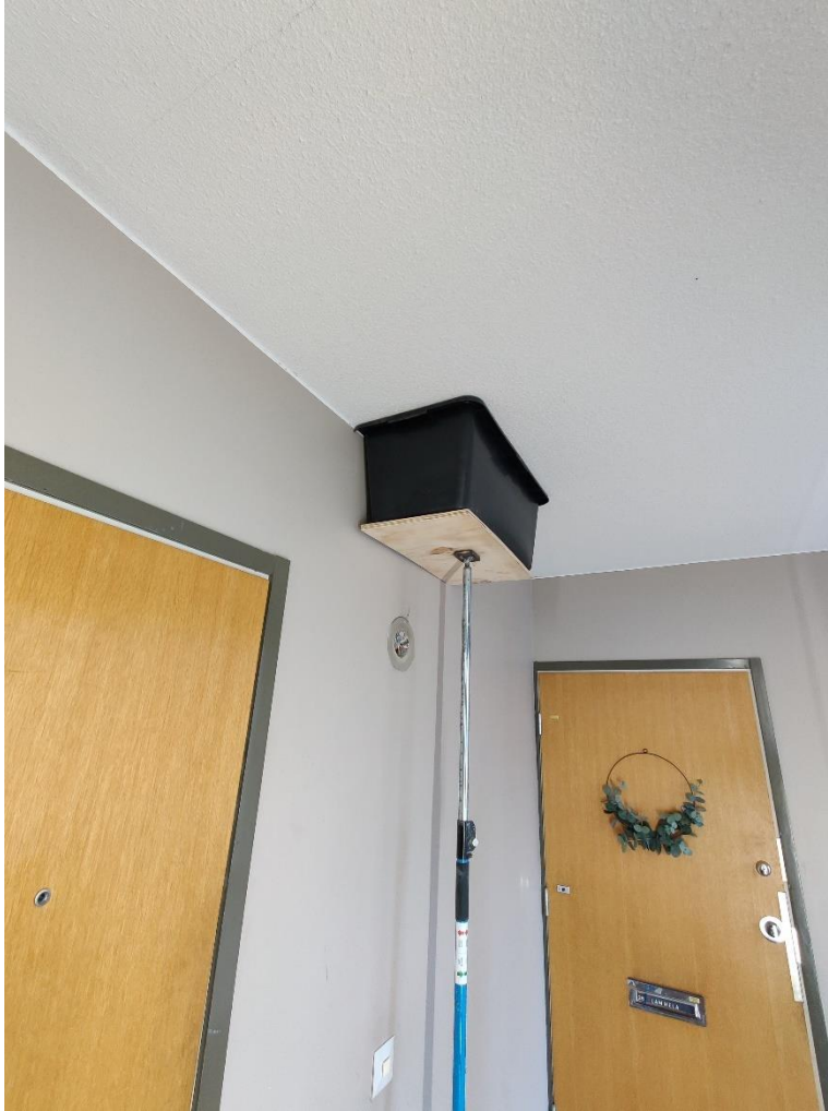
Kuva 15. Kiilattu keräilyastia poraustyön aikana alemmassa kerroksessa.
