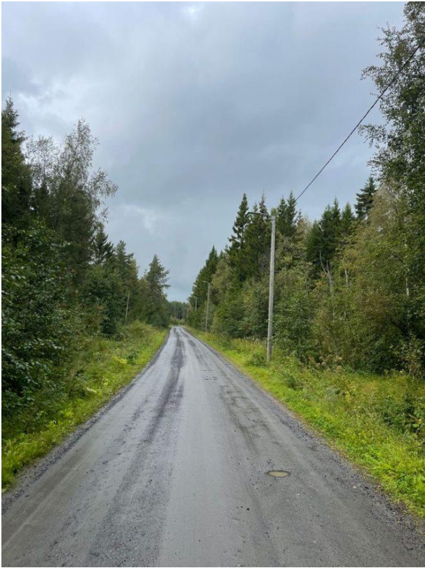
KUVA 7. Piimäperäntie. 16.8.2021. Ennen korjaustoimenpiteitä.
