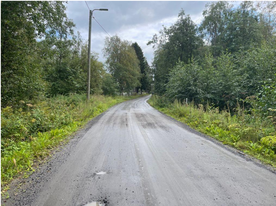
KUVA 3. Piimäperäntie. 16.8.202. Ennen korjaustoimenpiteitä
