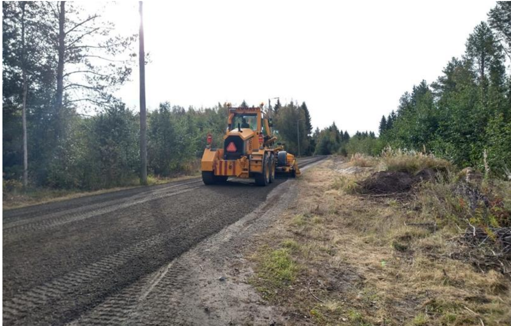
KUVA 13. Piimäperäntien sorastus. 7.9.2021. (Kuva: VRJ)
