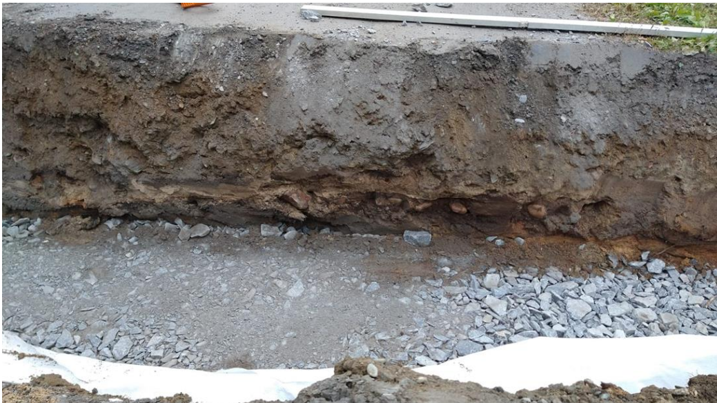
KUVA 12. Rummun vaihtotyö Piimäperäntiellä. 2.9.2021. (Kuva: VRJ)
