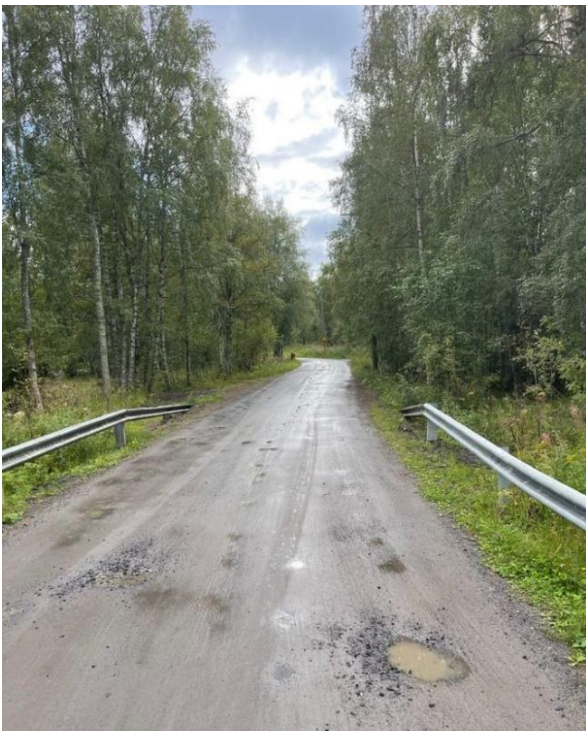
KUVA 8. Piimäperäntie. 16.8.2021. Ennen korjaustoimenpiteitä
