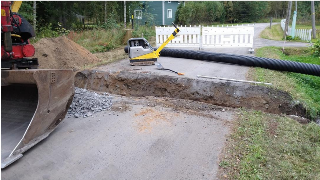
KUVA 11. Vanhat tierakenteet Piimäperäntie. 2.9.2021. (Kuva: VRJ)
