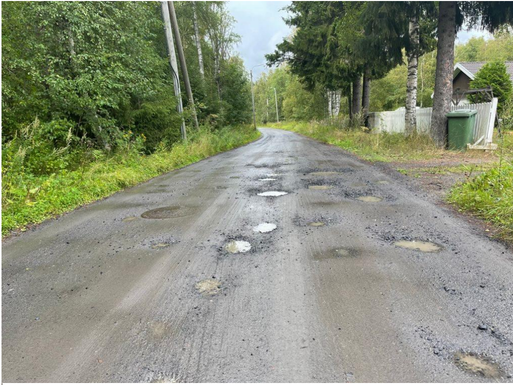
KUVA 5. Piimäperäntie. 16.8.2021. Ennen korjaustoimenpiteitä.
