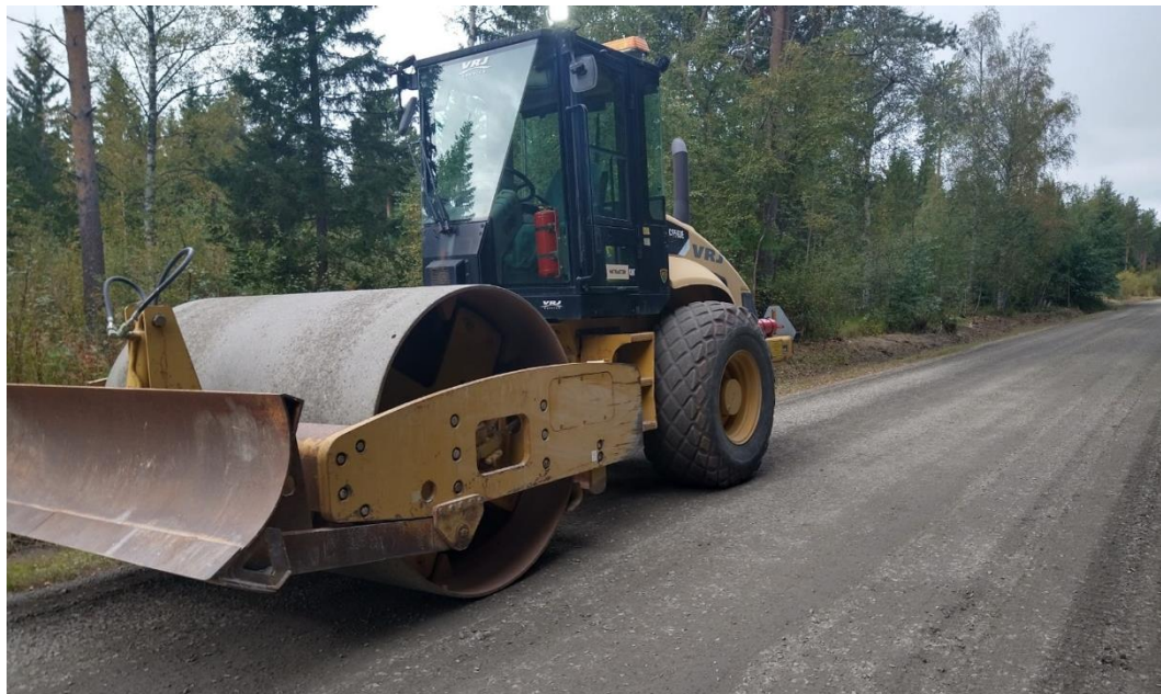
KUVA 14. Piimäperäntien jyräys. 7.9.2021. (Kuva: VRJ)
