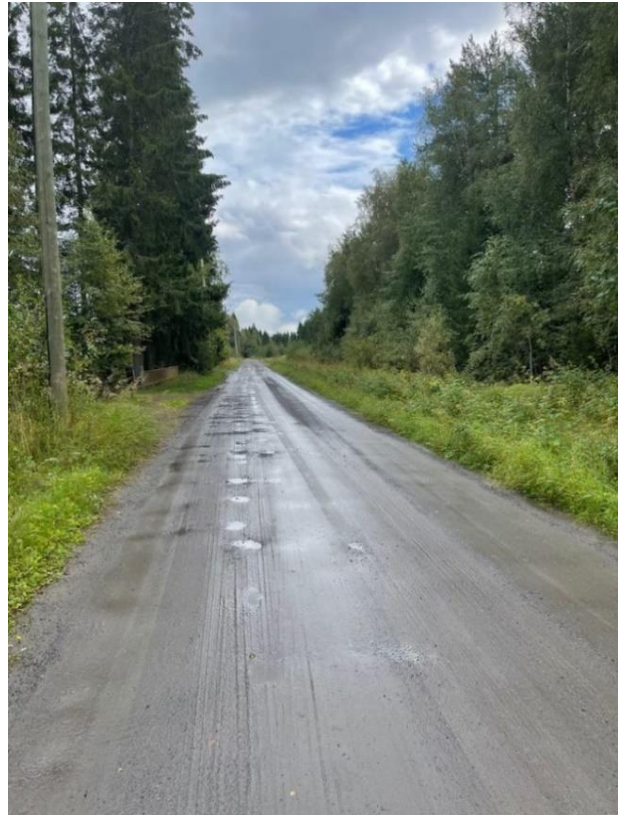
KUVA 6. Piimäperäntie. 16.8.2021. Ennen korjaustoimenpiteitä.
