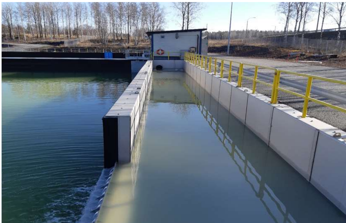
KUVA 4. Esiselkeytysallas on kuvassa keskellä, jonka pohjalle suolasaostumat laskeutuvat.
