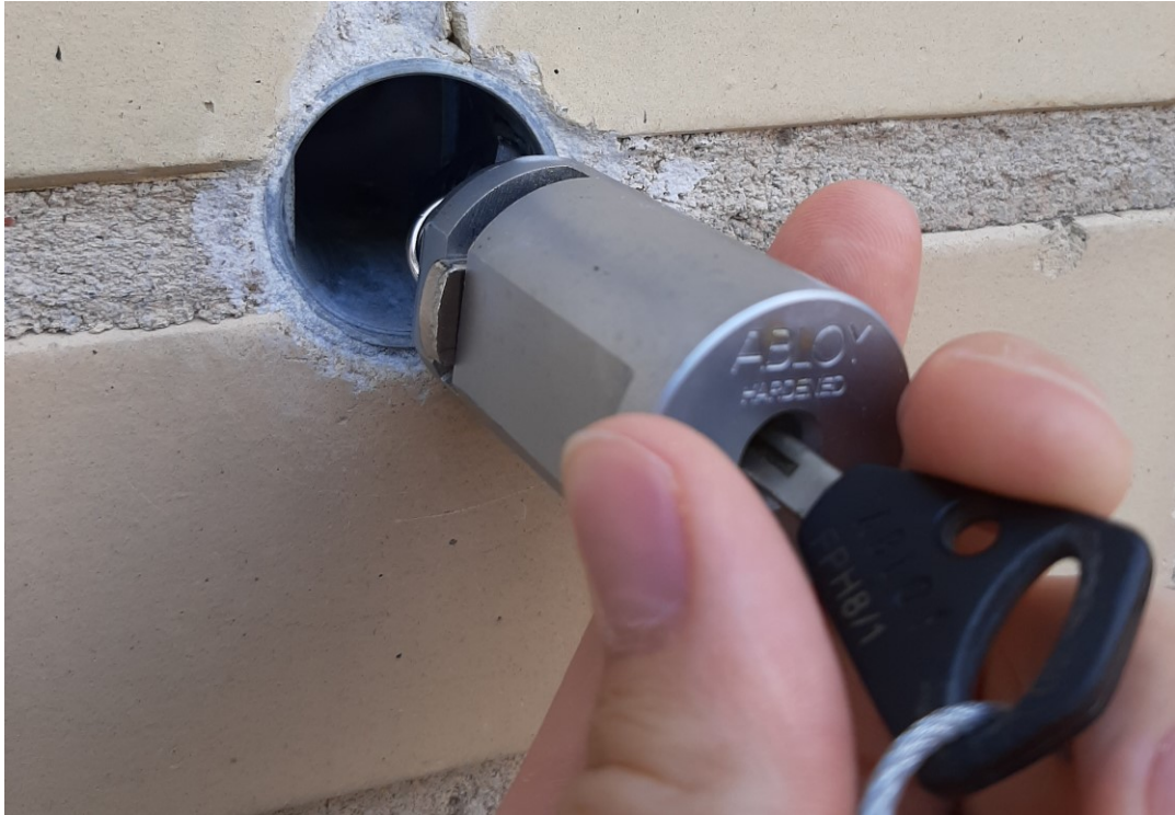
Kuva 5. VEKU-alueella käytettävä avainsäilö ja avainpesä. Avainpesään on kiinnitetty kohteen energiatiloihin johtavan kulkureitin reittiavaimet, ja niitä säilytetään seinään poratussa avainsäilössä.
