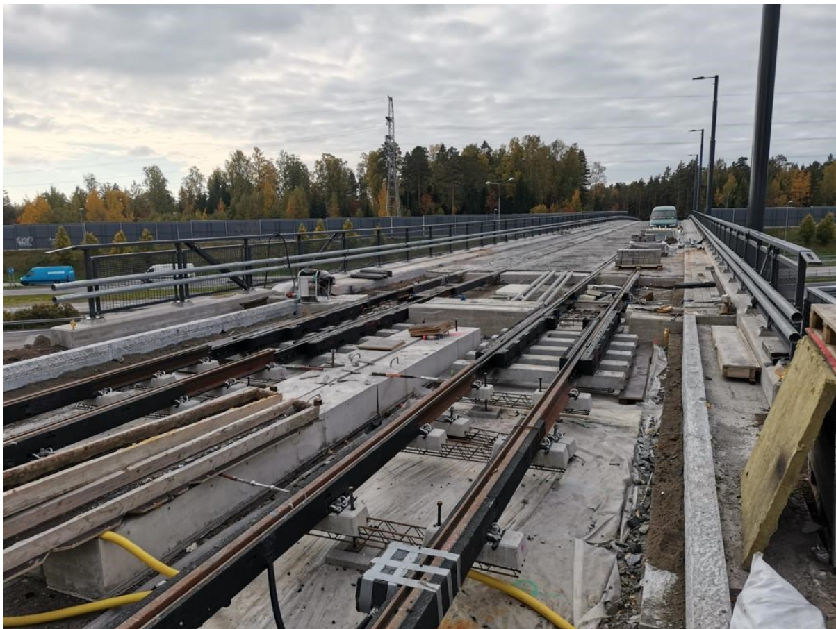
Kuva 14, Kiskonliikuntalaite Impilahden sillalla, Espoossa. Kuva: Arttu Kettunen
