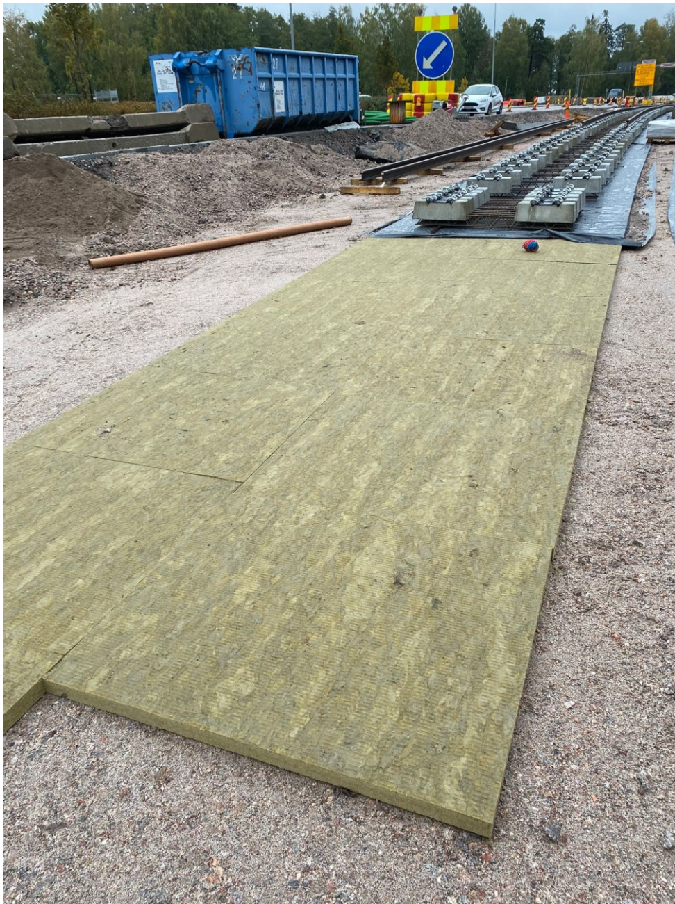
Kuva 1, Runkomelueristeen päälle rakennettu 49E1-rata. Kuva: Arttu Kettunen
