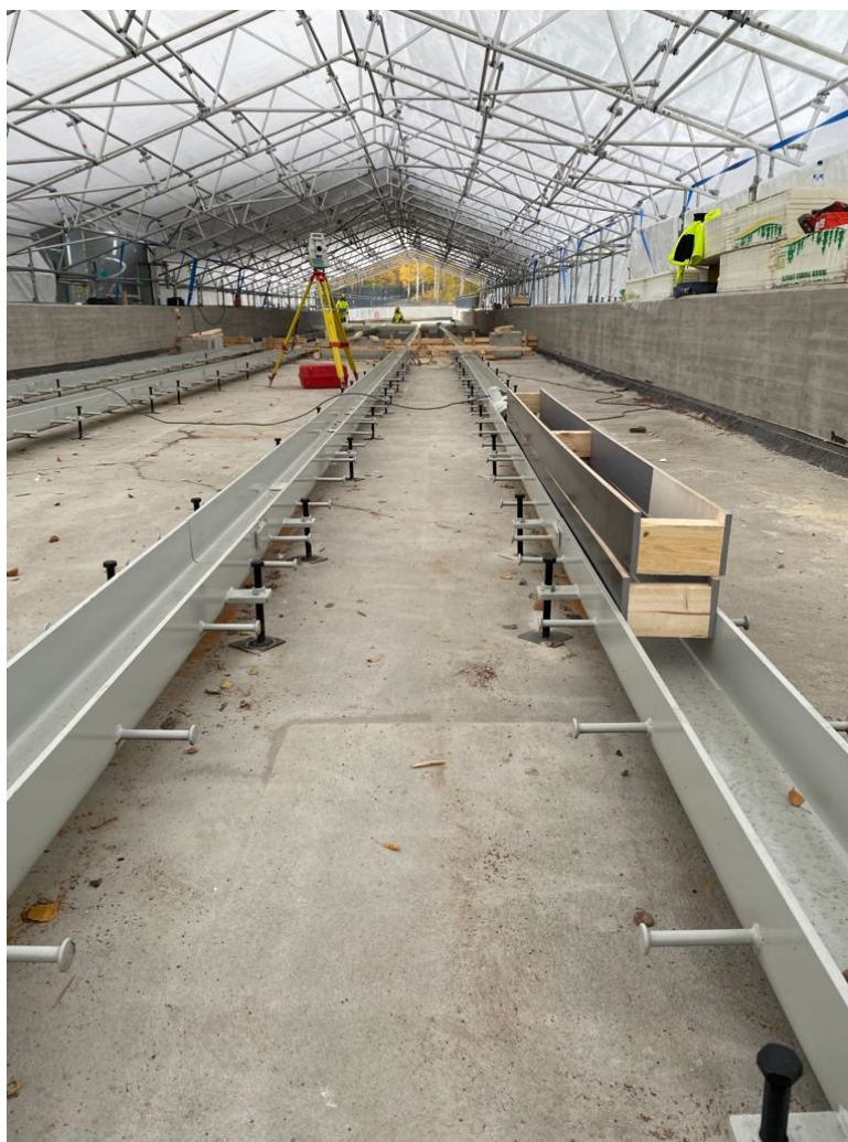
Kuva 6, Teräskourujen asemointia oikeaan geometriaan. Kuva: Arttu Kettunen
