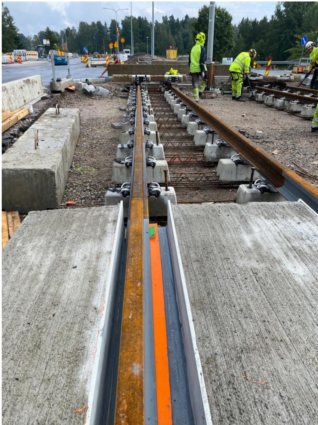
Kuva 9, ERS-teräskoururakenne yhdistyy 49E1-puolipölkkyrakenteeseen. Kuva: Arttu Kettunen
