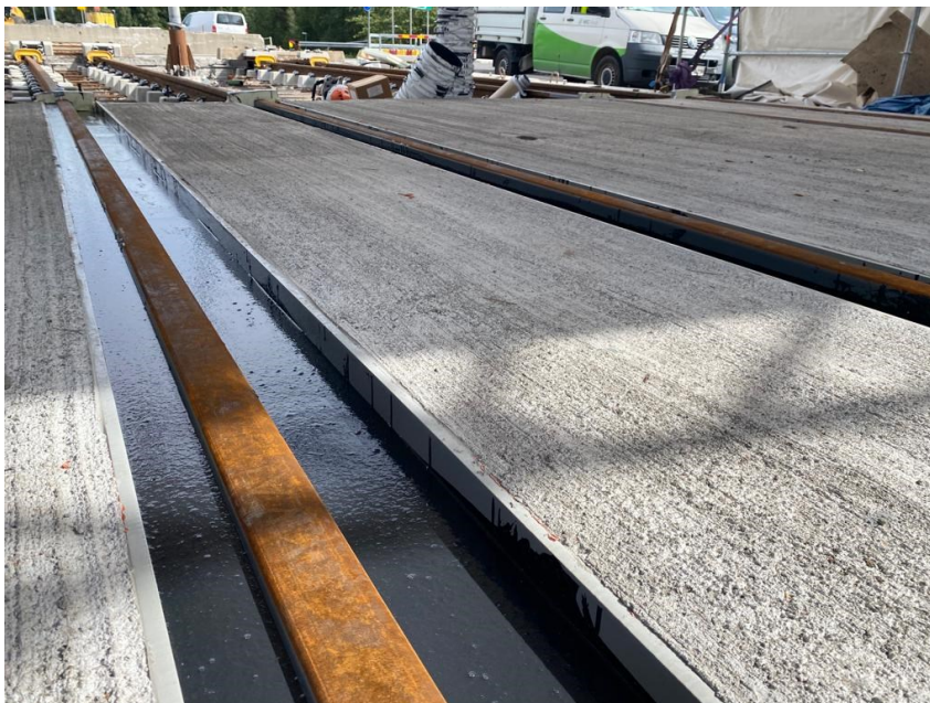
Kuva 10, Valmis ERS-rakenne. Kuva: Arttu Kettunen
