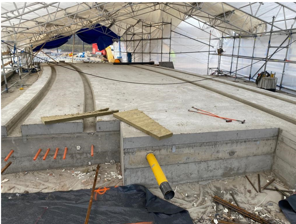
Kuva 12, Valmis ERS-betonikoururakenne. Kuva: Arttu Kettunen
