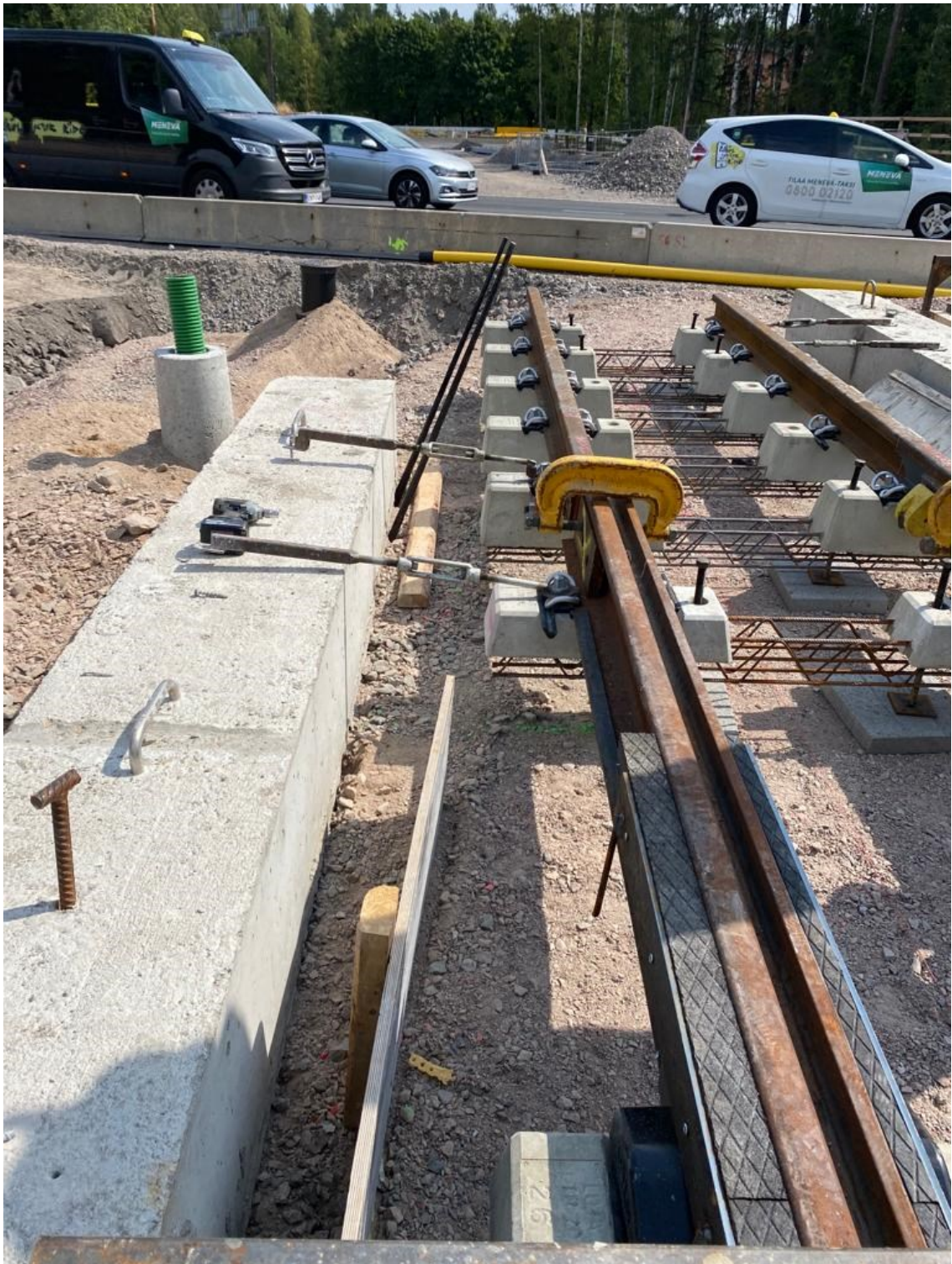
Kuva 4, 60R2-kiskot yhdistyvät 49E1-kiskoihin. Kuvasta näkee 60R2-kiskotyypin pidemmän pölkkävälän sekä pölkyissä olevat korkopultit, joilla raide asennetaan ja jotka nostetaan pois valun jälkeen. Kuva: Arttu Kettunen
