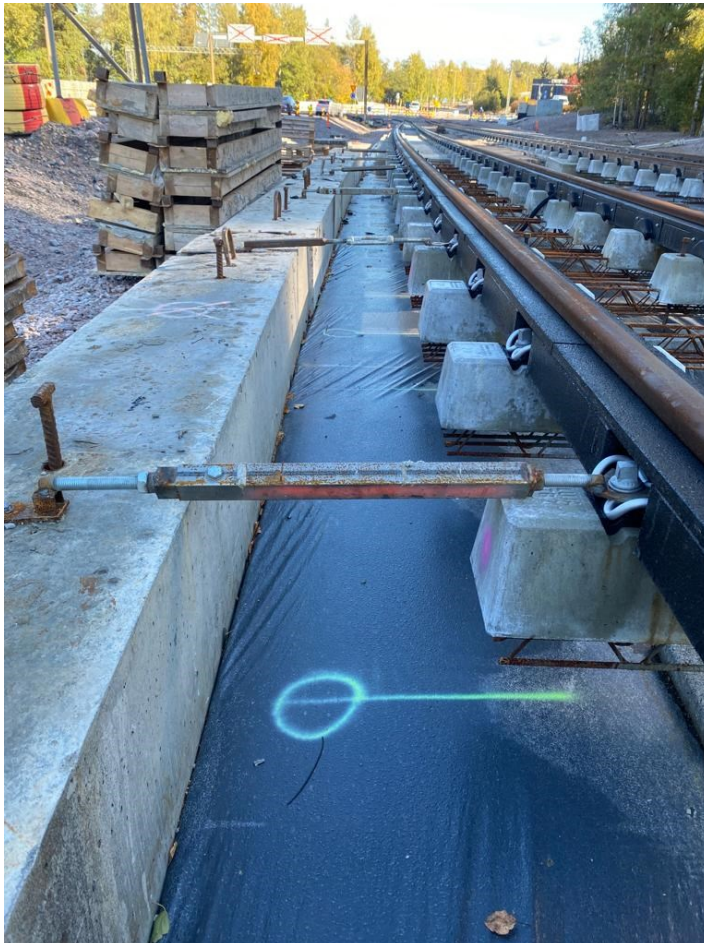
Kuva 3, Kiskon asemointiin käytettävät säätövantit ja betonipainot. Kuvassa kisko eristetty oikeaoppisesti kammiokumeilla. Kiskotyyppi 49E1. Kuva: Arttu Kettunen
