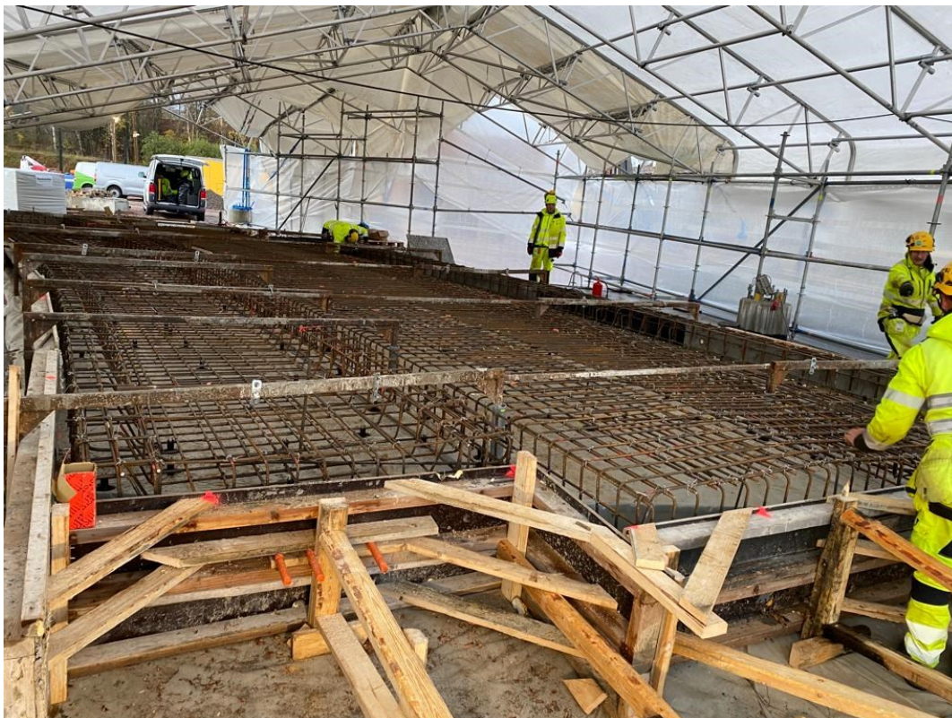
Kuva 11, Betonikourujen alle tuleva raudoite muotitettuna. Kuva: Arttu Kettunen
