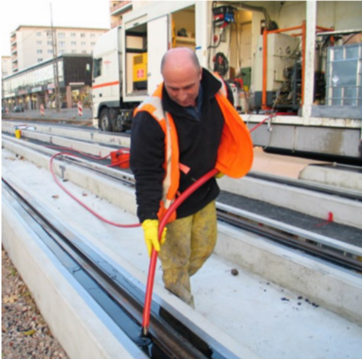
Kuva 17, Corkelastin käyttöön soveltuva pumppauskalusto. Kuva: Edilon Sedra
