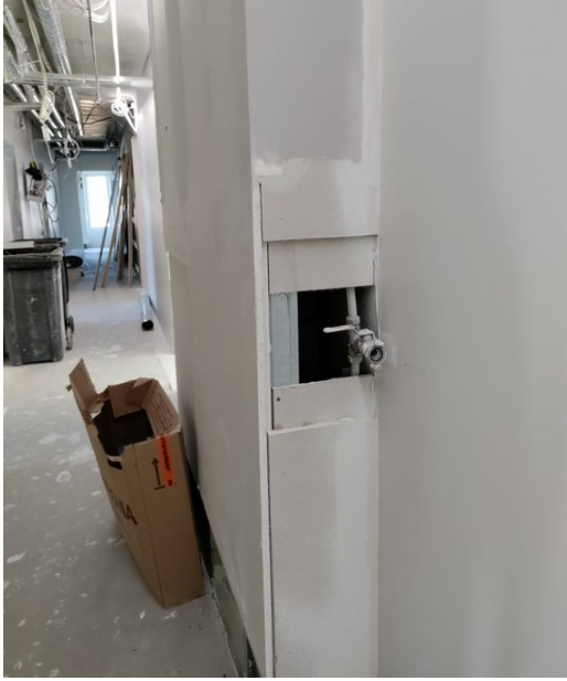
Kuva 9 - Työmaaveden kuljettaminen hormissa.
