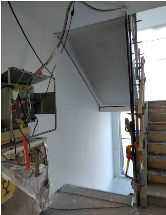
Kuva 11 - Työmaasähkön kuljettaminen portaiden yhteydessä.
