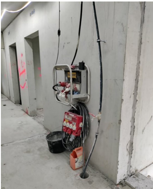
Kuva 10 - Työmaasähkön ja -veden kuljettaminen massiivilaatan läpi.
