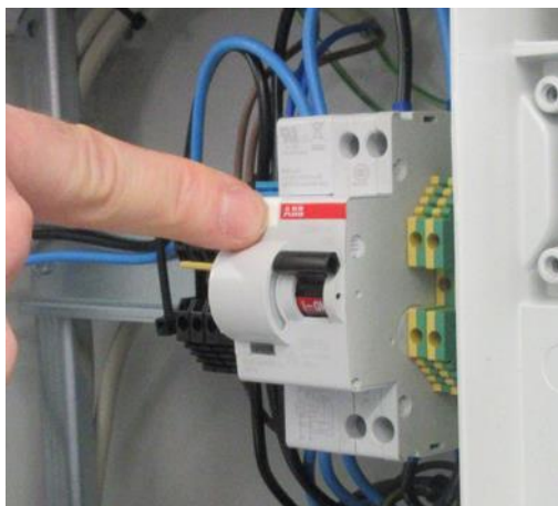
Kuva 53. Vikavirtasuoja ja testauspainike
