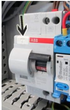
Kuva 39. ABB B6 vikavirtasuojaja. Testinäppäin merkittynä nuolella.
