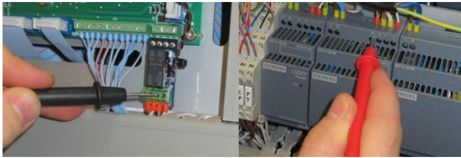
Kuva 11. 24 voltin johtimen mittaus.
