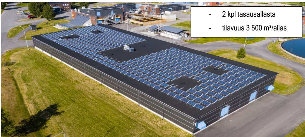
KUVA 8. Jätevedenpuhdistamon tasausallas ja katolle asennetut aurinkopaneelit (11)
