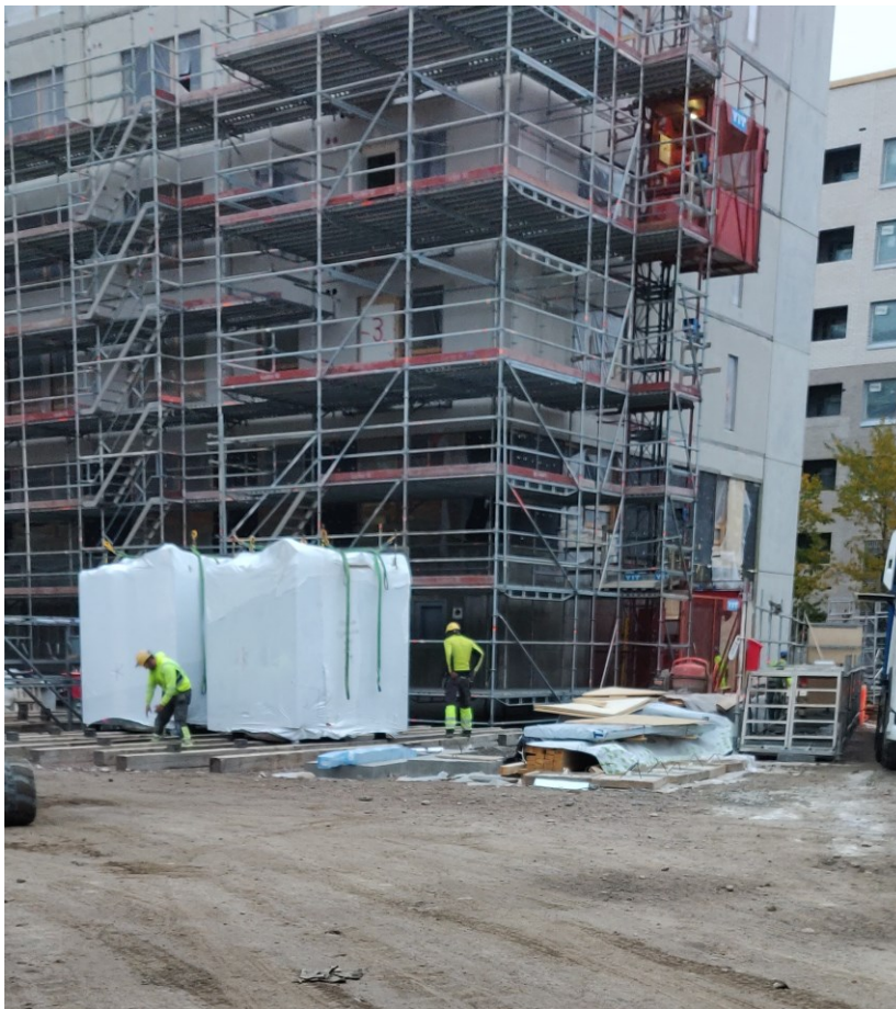
Kuva 24. Oikeassa kuvan reunassa, kylpyhuone-elementeille valmistettu välivarastointipaikka työmaalla. (Sillanpää, 2021.)
