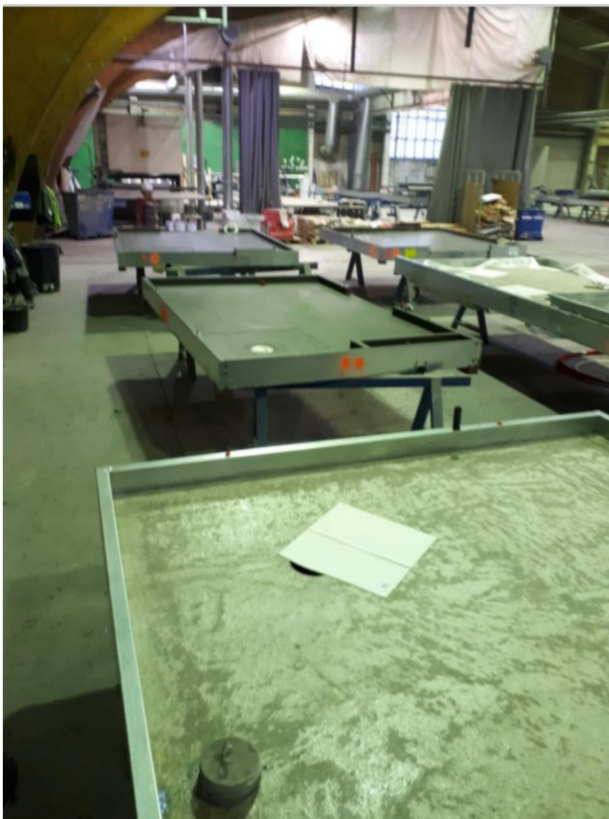
Kuva 9. Kylpyhuone-elementin pohjalaatta on kuivunut vedeneristystä ja laatoitusta varten valmiiksi. (Lampola, 2017: 9.)
