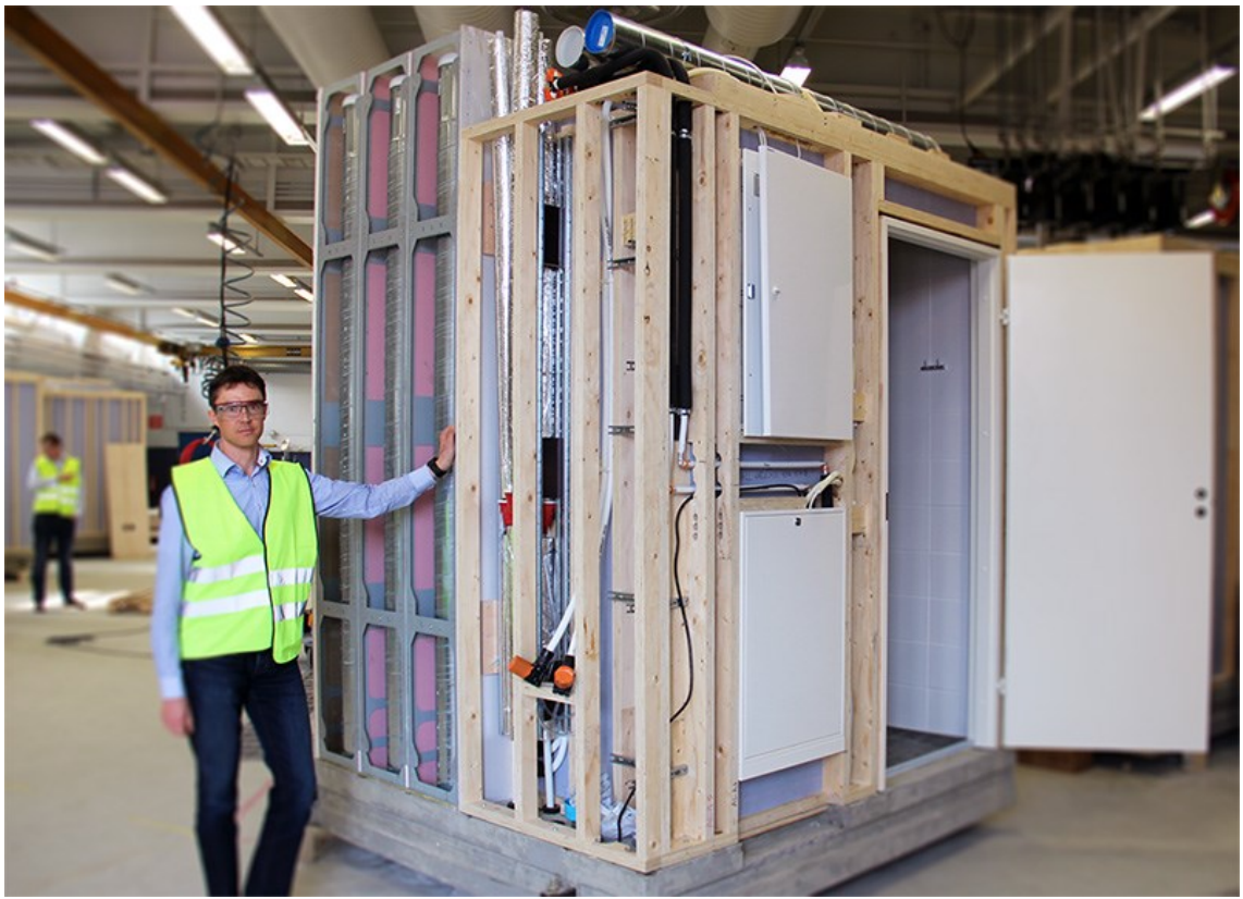
Kuva 3. Fira:n tuottama Fira Modules kylpyhuone-elementti v.2018–2019 (Firamodules.com)
