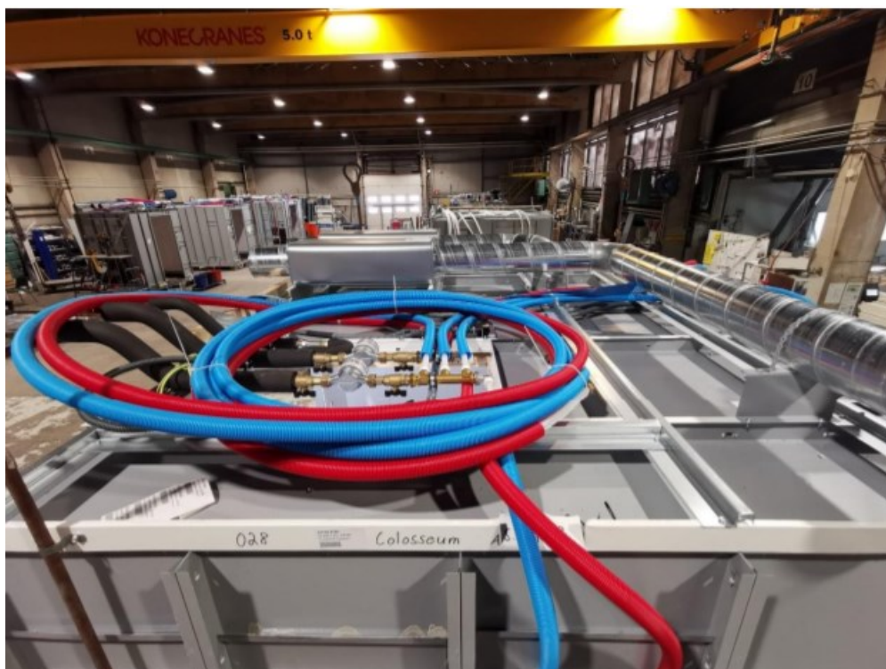
Kuva 13. Kylpyhuone-elementin katolla asennettuna elementtitehtaalla talotekniikka eli LVIS valmiiksi. (Eloranta, 2019: 10.)
