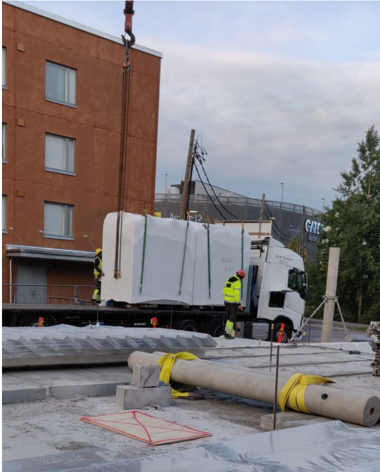
Kuva 21. KPH-elementtikuorma on saapunut työmaalle. (Sillanpää, 2021.)
