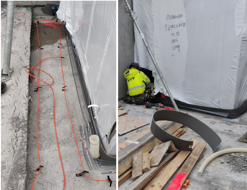
Kuva 29. Kylpyhuone-elementin reunavalun suorittamista. (Sillanpää, 2021.)
