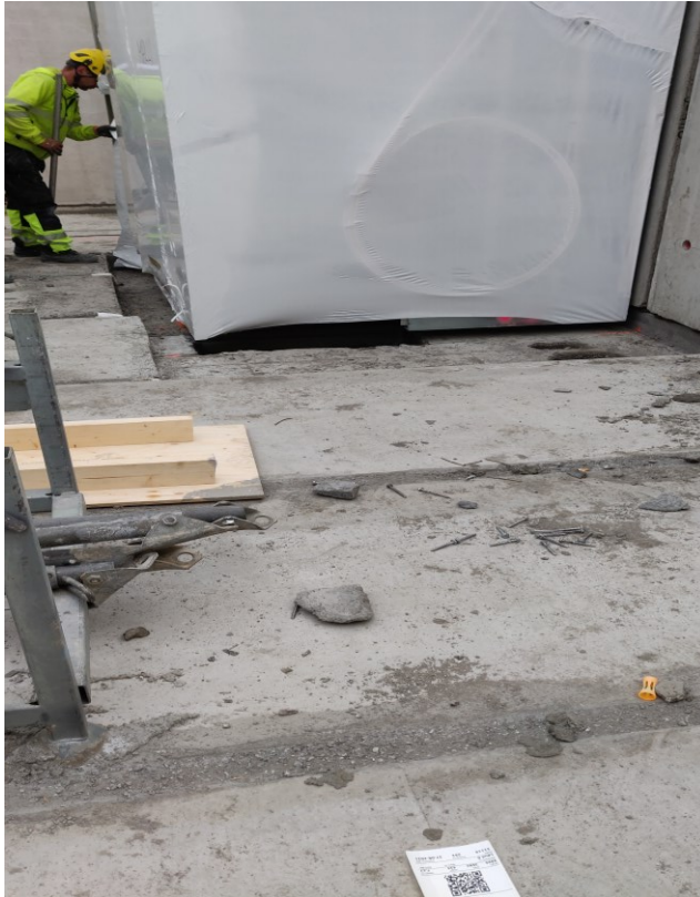
Kuva 25. Kylpyhuone-elementti asennuksessa täytyy katsoa tarkasti etäisyyttä kantavista betonirakenneseinistä. (Sillanpää, 2021.)
