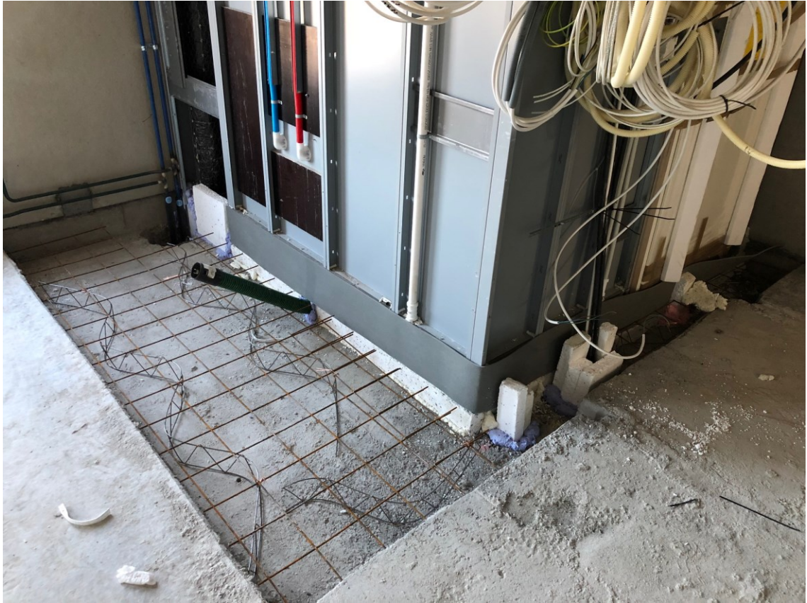
Kuva 30. Kylpyhuone-elementin reunavalun muottityöt valmiina suoritettuna. (YIT:n Vastaava työnjohtaja Hakkarainen, 2021.)
