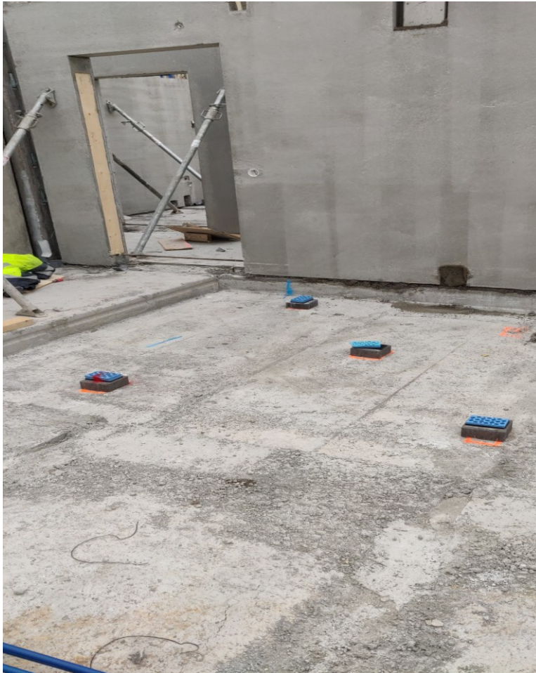
Kuva 18. Kylpyhuone-elementin kololaattasyvennyksessä on valmiina vaaitetuna oikeaan asennuskorkoon asennusvälikkeet. (Sillanpää, 2021.)
