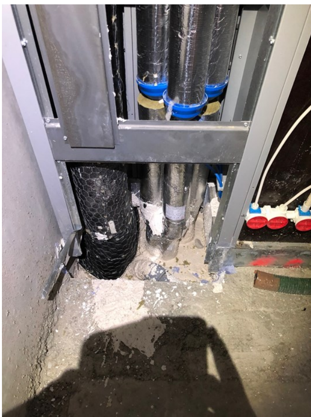
Kuva 33. Kylpyhuone-elementin tekniikkahormin palokatkojen asennus suoritettuna. (YIT:n Vastaava työnjohtaja Hakkarainen, 2021.)
