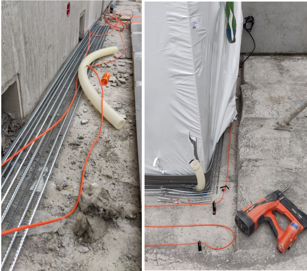
Kuva 28. Kylpyhuone-elementin reunavalun muottityömateriaaleja- ja asentamista. (Sillanpää, 2021.)
