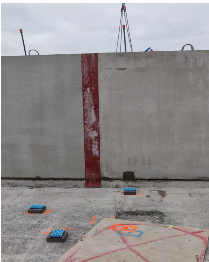
Kuva 19. Kantavassa betonirakenneseinässä valusaumapelti asennettu. (Sillanpää, 2021.)
