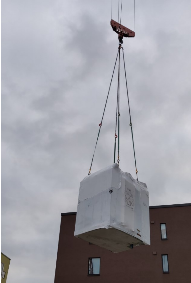
Kuva 22. Kylpyhuone-elementin mukana tulevat nostoliinat käytössä. (Sillanpää, 2021.)
