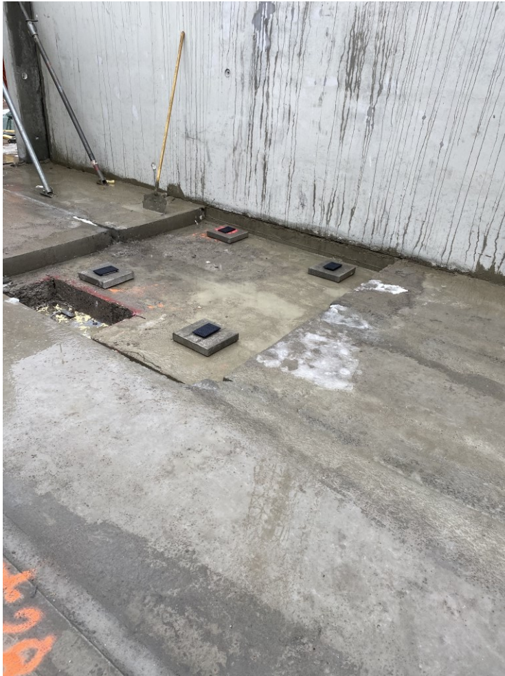
Kuva 17. Ontelolaattavälipohjassa oleva kololaattasyvennyks kylpyhuone-elementille. (Vastaava työnjohtaja Hakkarainen, 2021.)
