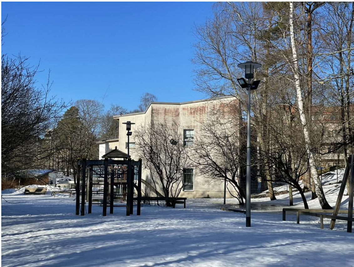
KUVA 8: Piilopirtin eteläjulkisivu on päässyt huonoon kuntoon (Hauvala 2021).
