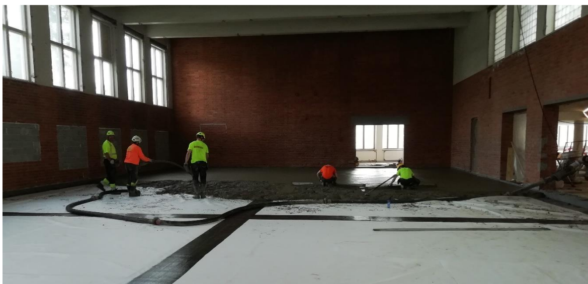
Kuva 8. Maanvaraisen lattian valu kuitubetonilla (Kuva: Ilkka Torniainen)
