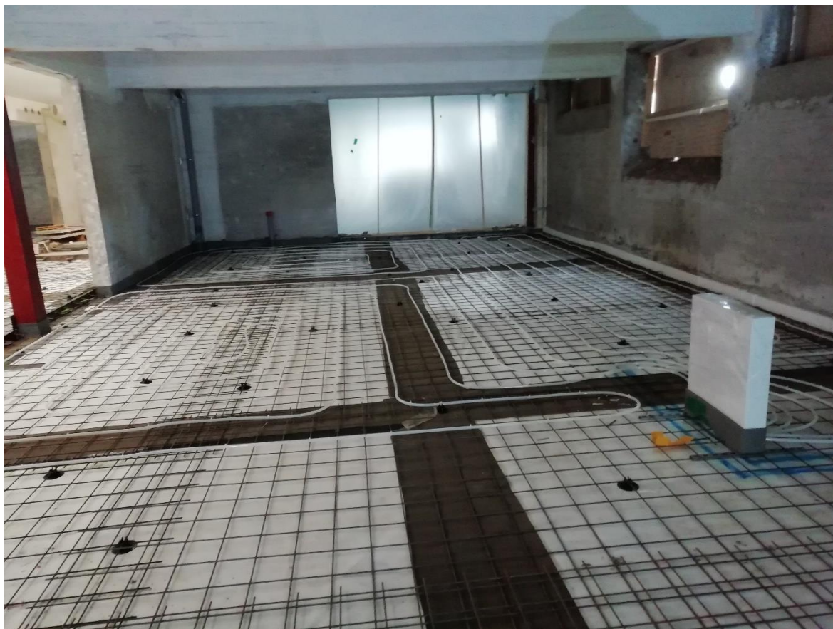
Kuva 3. Lattialämmitysputkisto asennettuna betoniraudoiteverkkoihin (Kuva: Ilkka Torniainen)
