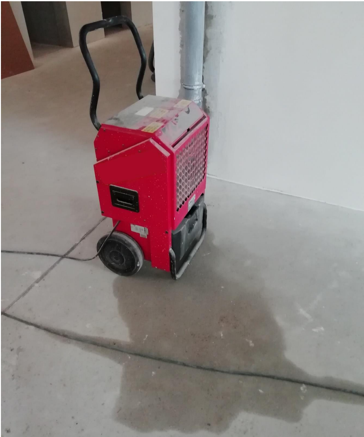
Kuva 11. Ylivuotanut ilmankuivain (Kuva: Ilkka Torniainen)
