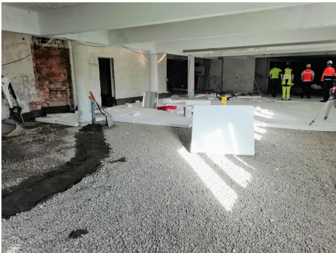
Kuva 2. Kapillaarikatkosorakerros ja eristelevyjen asennus (Kuva: Ilkka Tornainen)
