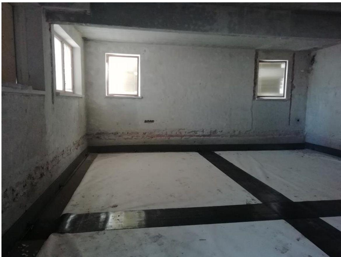
Kuva 4. Asennetut radonsuojaukset sekä irrotuskaistat (Kuva: Ilkka Torniainen)
