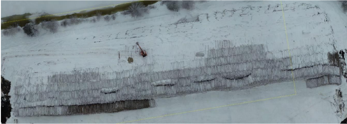
Kuva 7 Kylmävarasto rakennusvaiheessa (Mutanen 2021a)
