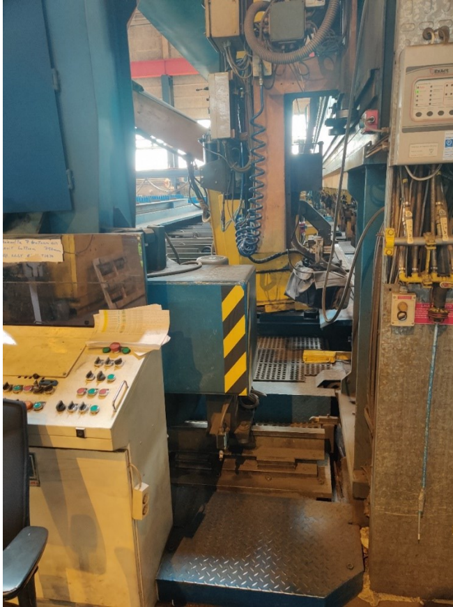
Kuva 9. Reitti palkituskoneen liikkumisalueelle.
