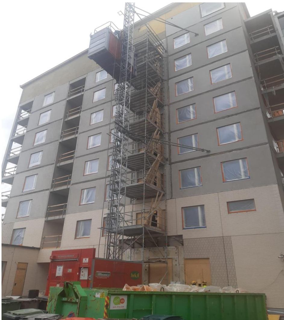
Kuva 6. Rakennushissi työmaakäytössä (Simola 2020)
