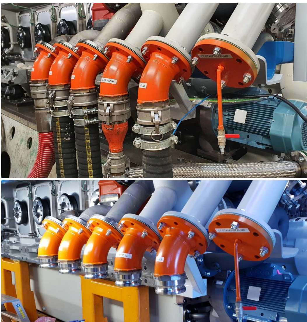
Kuva 3. Camlock-putket kokoonpanossa ja sellissä.
