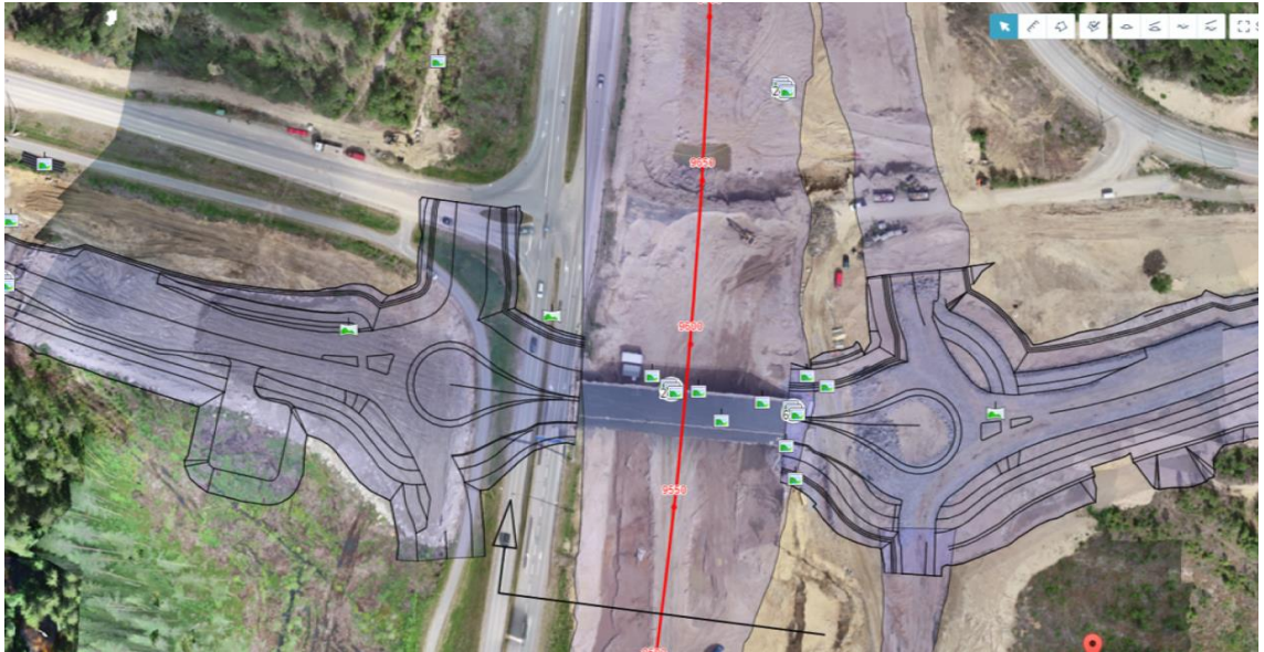
Kuva 7. Ilmakuva eritasoliittymän alueelta töiden alkuvaiheessa (Jaakkola 2021)
