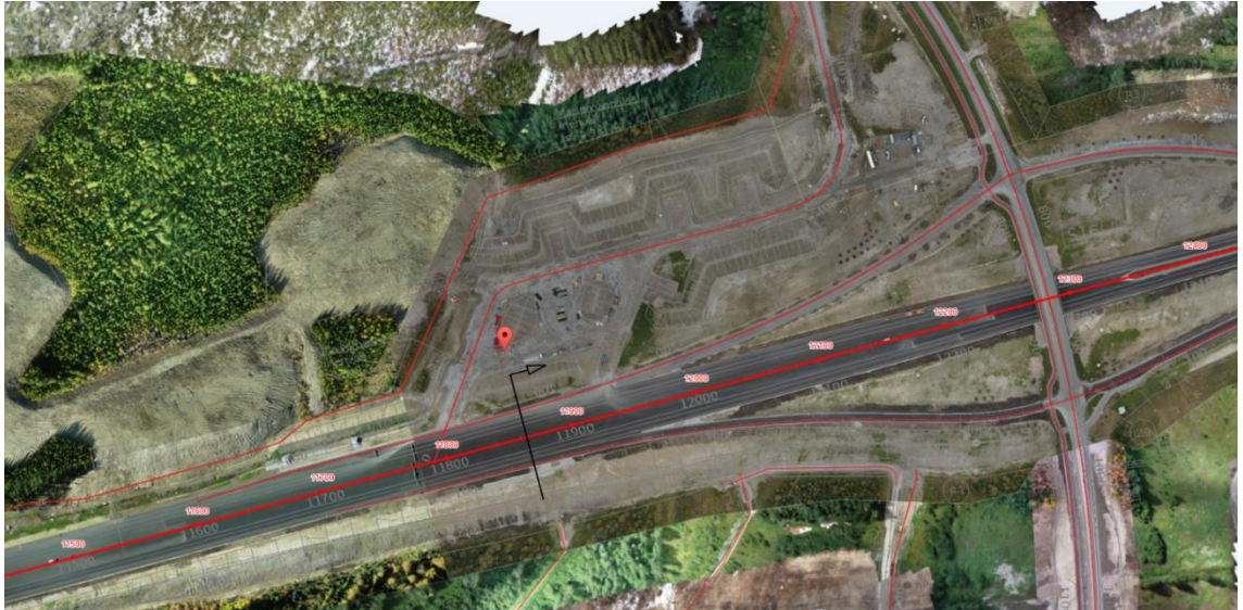
Kuva 10. Ilmakuva eritasoliittymän alueelta valmiista rakenteista (Leinonen 2021)
