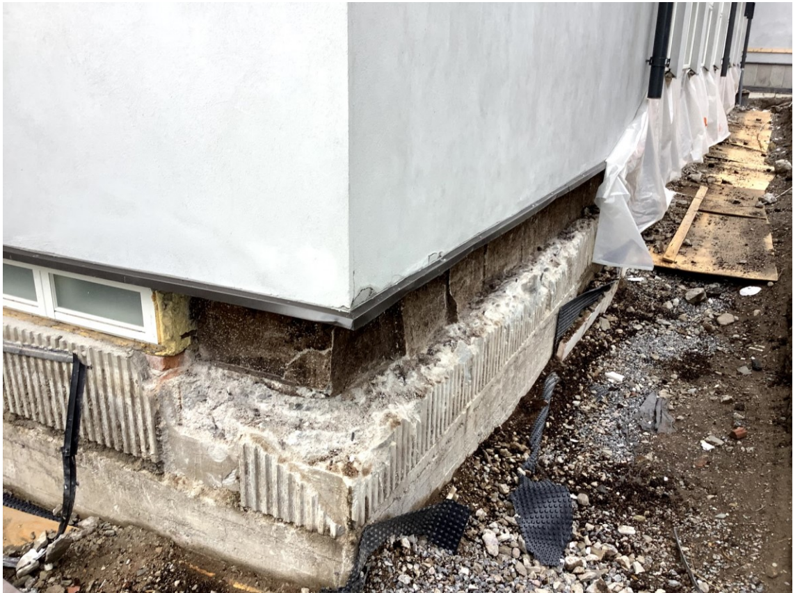
Kuva 3. Kivihiilipikeä sisältävä vedeneristys sokkelin sisällä (Sjöberg 4/2019)
