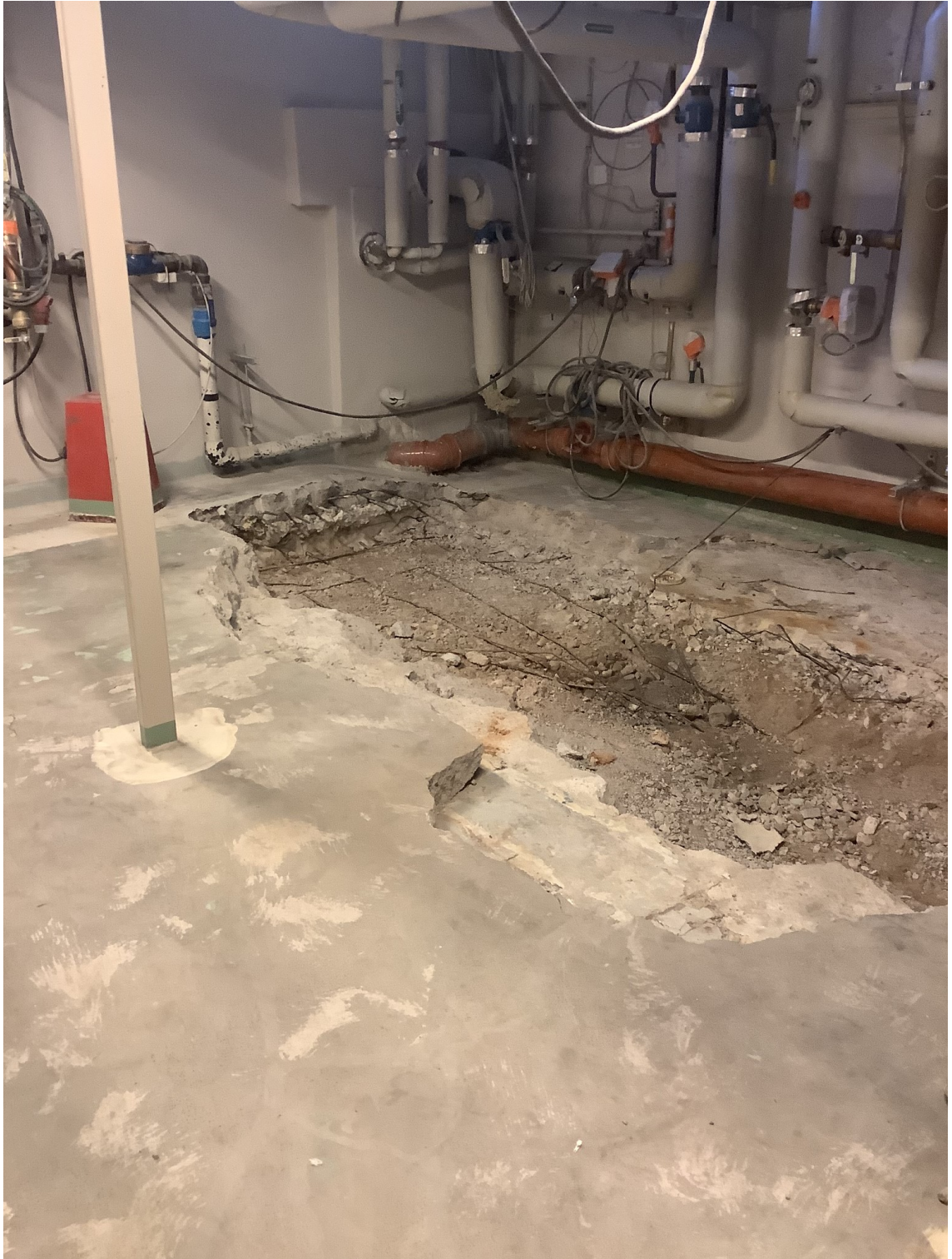
Kuva 4. Öljyä sisältävän betonilaatan purku (Sjöberg 9/2019)
