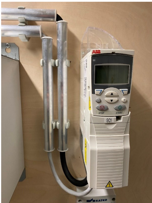
Kuva 15. Alumiiniputket johtoreittinä keskukselta taajuusmuuttajalle.
