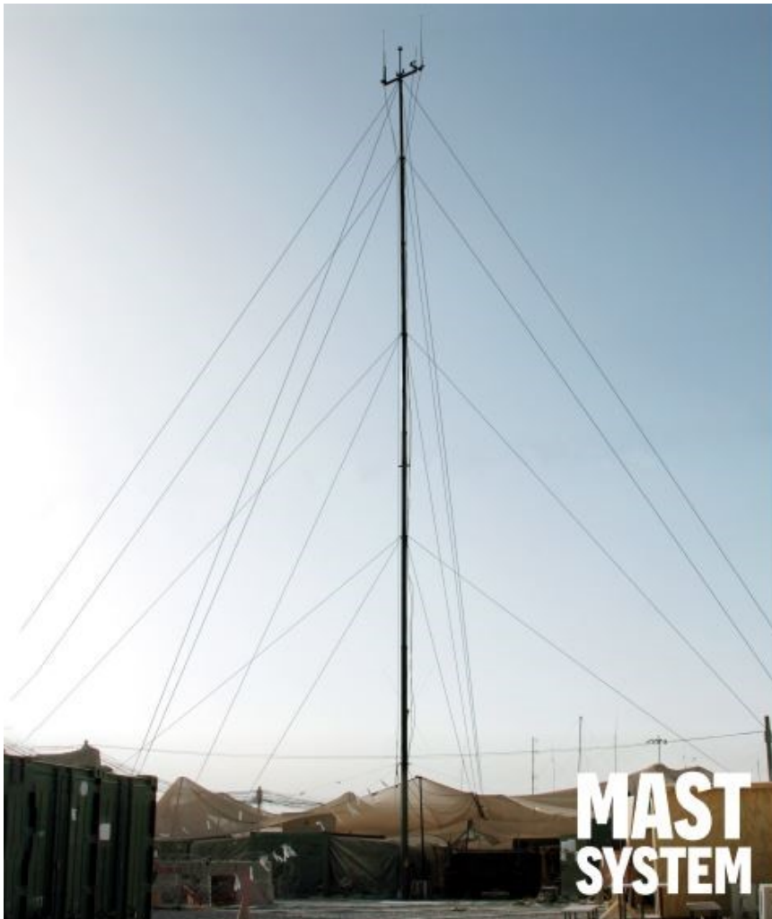
Kuva 1. Kuvassa EXL-masto (Kuva: Mastsystem Int'l Oy.).
