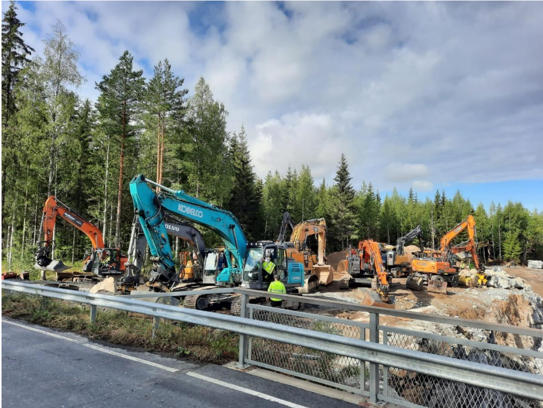
KUVA 10. 10 tunnin liikennekatkon kaivinkoneet
