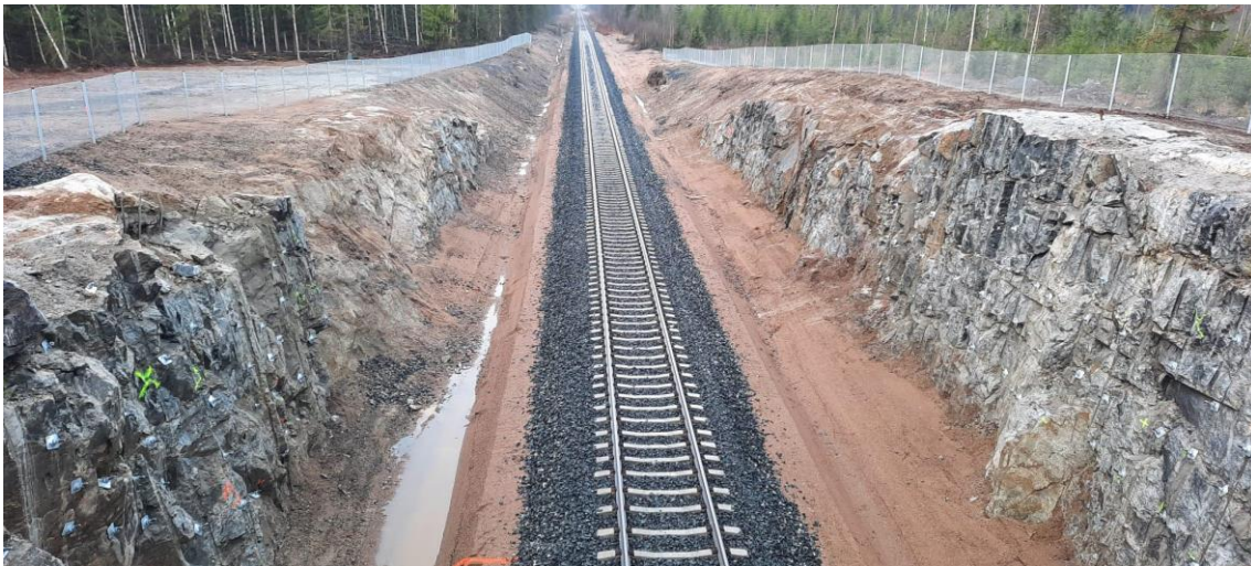
KUVA 12. Tossavaisen ylikulkusillan raiteenrakennustyöt valmistuneet
