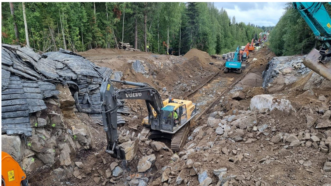
KUVA 7. Maaleikkausta ja louhintaa
