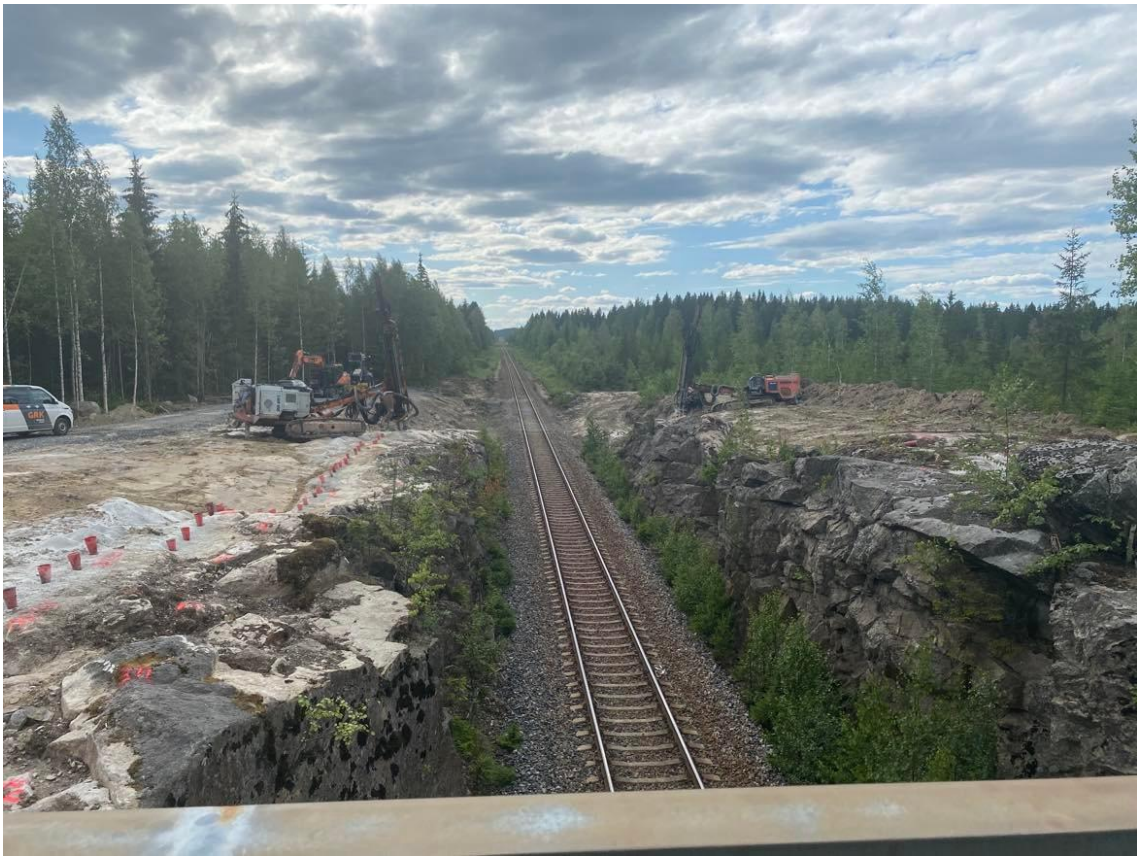
KUVA 11. Tossavaisen ylikulkusillan kallioporaus käynnissä
