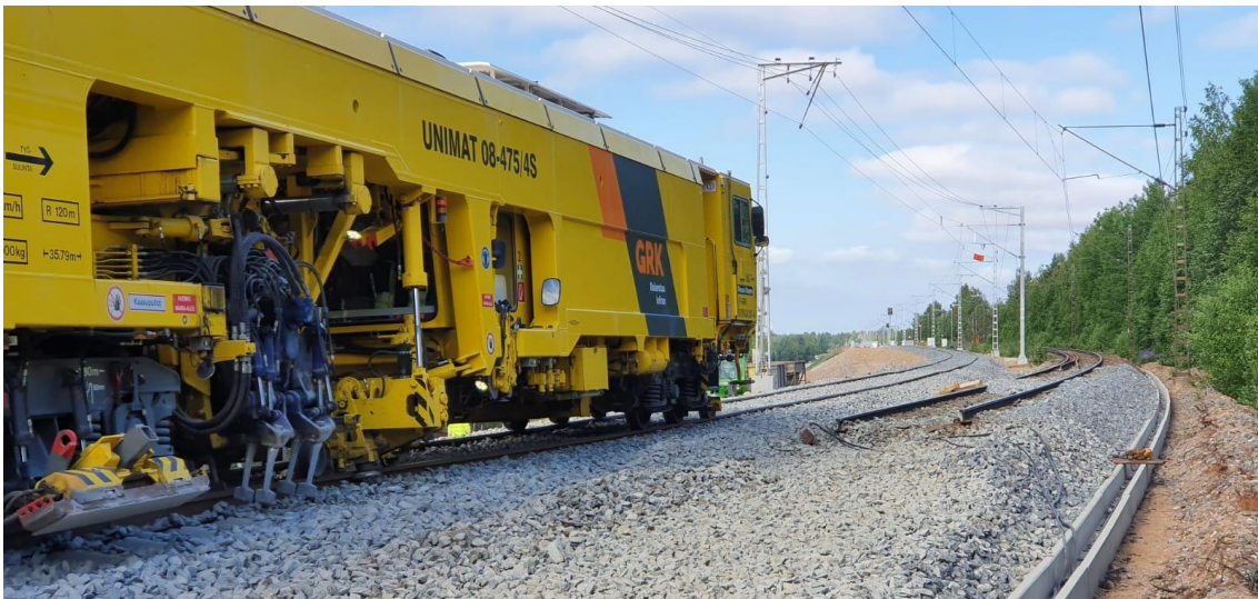
KUVA 3. Grk Rail Oy:n raiteentukemiskone
