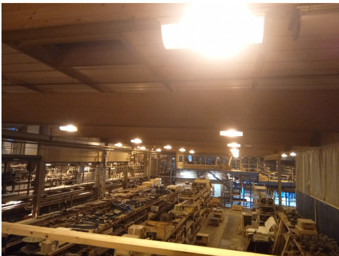
Kuva 10. Nykyinen valaistustilanne varasto alueen päältä. (Topi Venäläinen, 2021)
