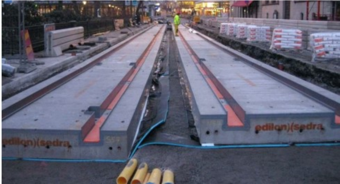
Kuva 17. Raitiotien runkomelueriste (sinimusta matto) pohjalaatan alapuolella.
