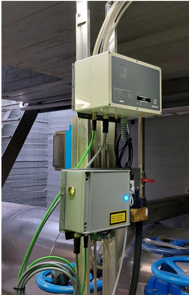
Kuva 2: Uponorin laite ilman suojakuorta Pirttiharjun paineenkorotusasemalla.
