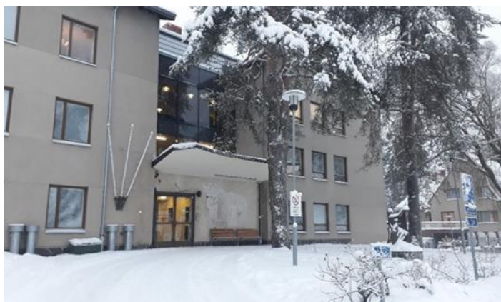
Kuva 7. Alava A1 ulkoa, pääsisäänkäynti osassa 1 (Jormakka 2021, CC BY-NC-ND)
