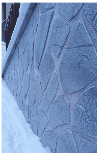
Kuva 3. Julkisivun liuskekiviverhousta (Jormakka 2021, CC BY-NC-ND)
