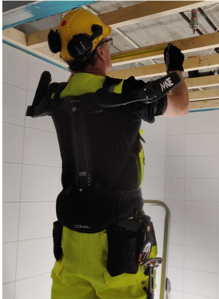
Kuva 8. Comau MATE XT käytössä kylpyhuoneen kattokoolaustöissä.
