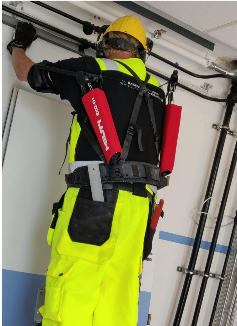
Kuva 7. Hilti EXO-01 käytössä porraskäytävän koolaustöissä.
