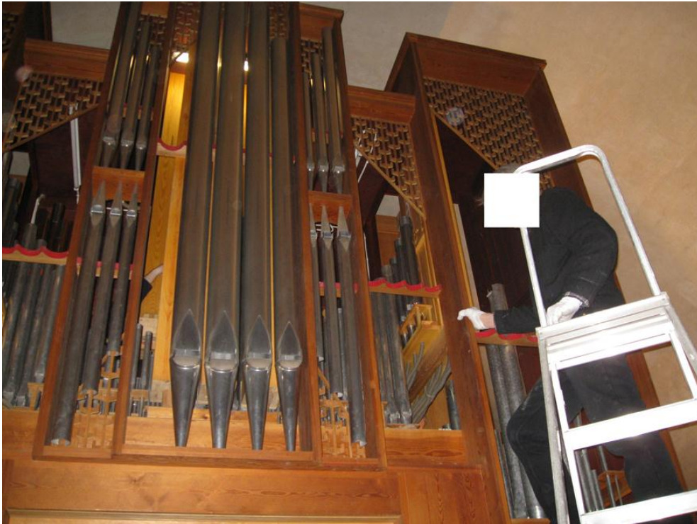
Julkisivun pillien purkaminen. Kuva: Pekka Tyni.
