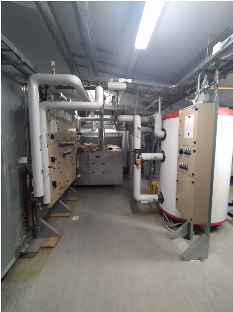
Kuva 2. Tekninen ullakko eräässä optimoitavassa kiinteistössä.
