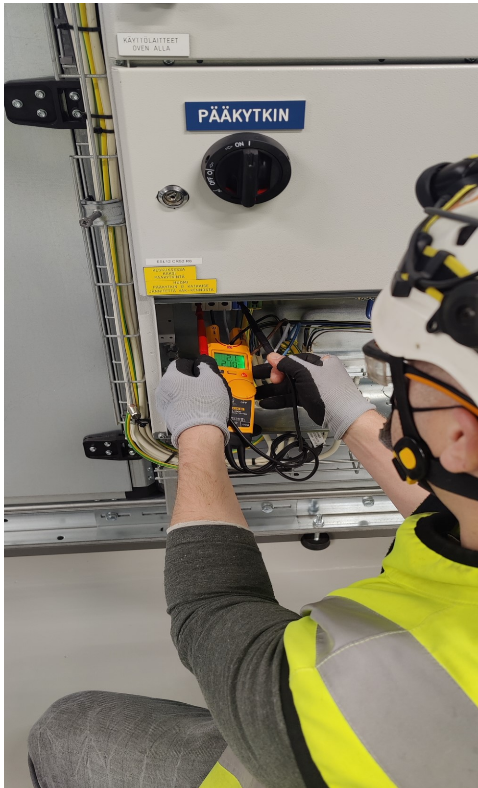
Kuva 22. Kuvan kaltaista virtapihtimittaria ei tulisi käyttää ilmanvaihtokoneen ottaman sähkötehon mittaamiseen.
