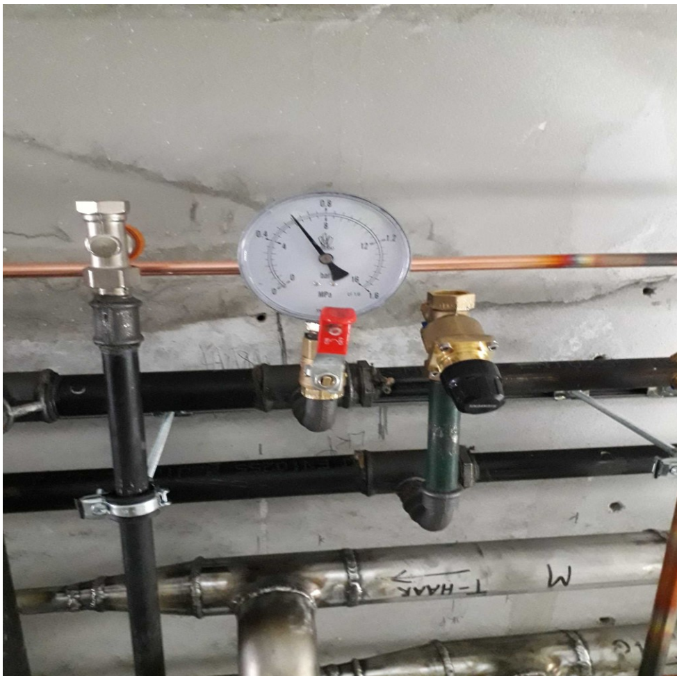
Kuva 12. Lämmitysputkiston osapainekoe. Painekokeessa pidettiin putkistossa 6 baarin paine kahden tunnin ajan.
