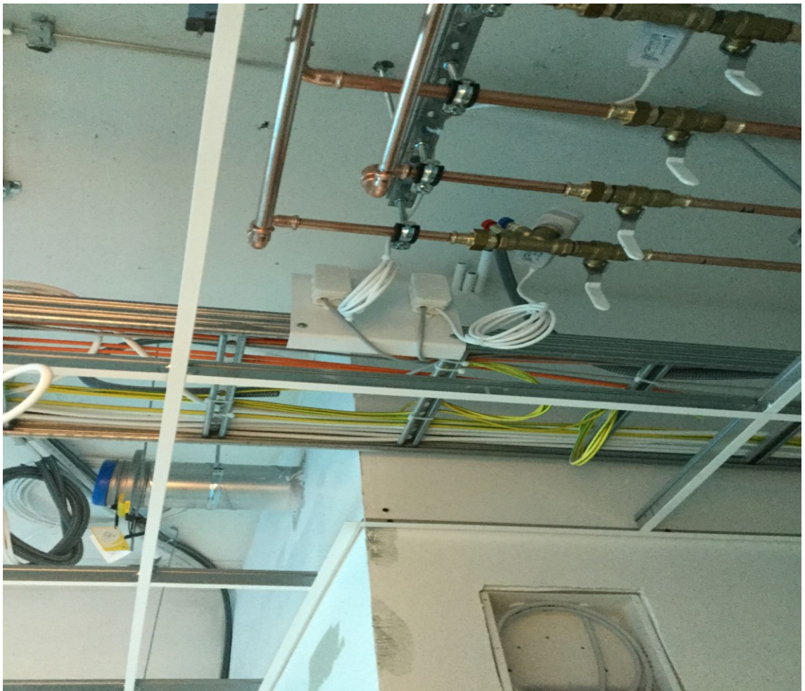
Kuva 10. Kattosäteilijän toimilaitteiden malliasennus. Malliasennus dokumentoitiin Congridiin.
