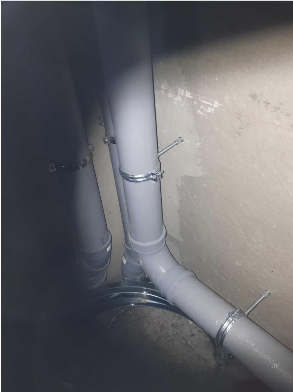
Kuva 11. Tuuletusviemärin kannakointien asennustapatarkastus. Hyväksytyt asennukset.
