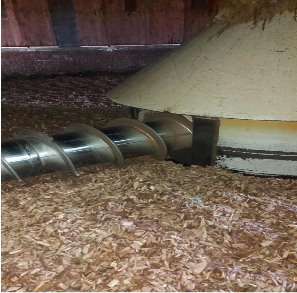
Kuva 8. Aittaluodon turvesiilo puupolttoaineella.
