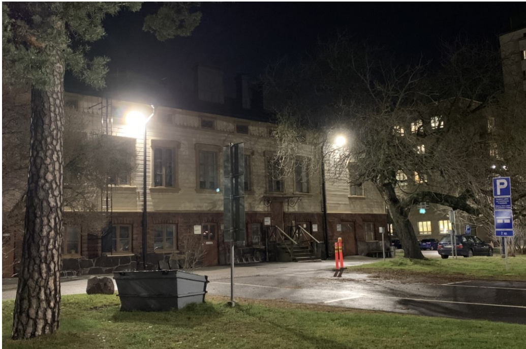
Kuva 13. Rakennus 3 uudet valonheittimet ulkoseinässä.
