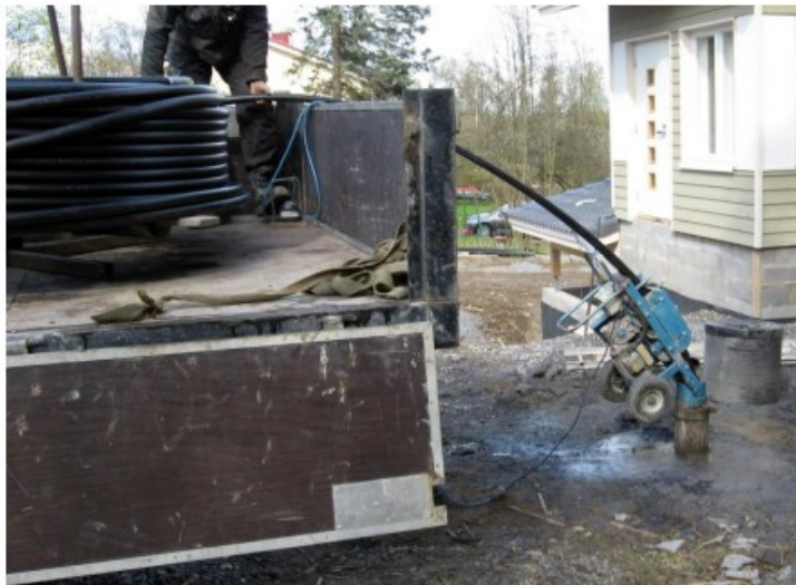
Kuva 6. Keruuputken syöttö syöttölaitteella. [8] (Energiakaivo-opas)
