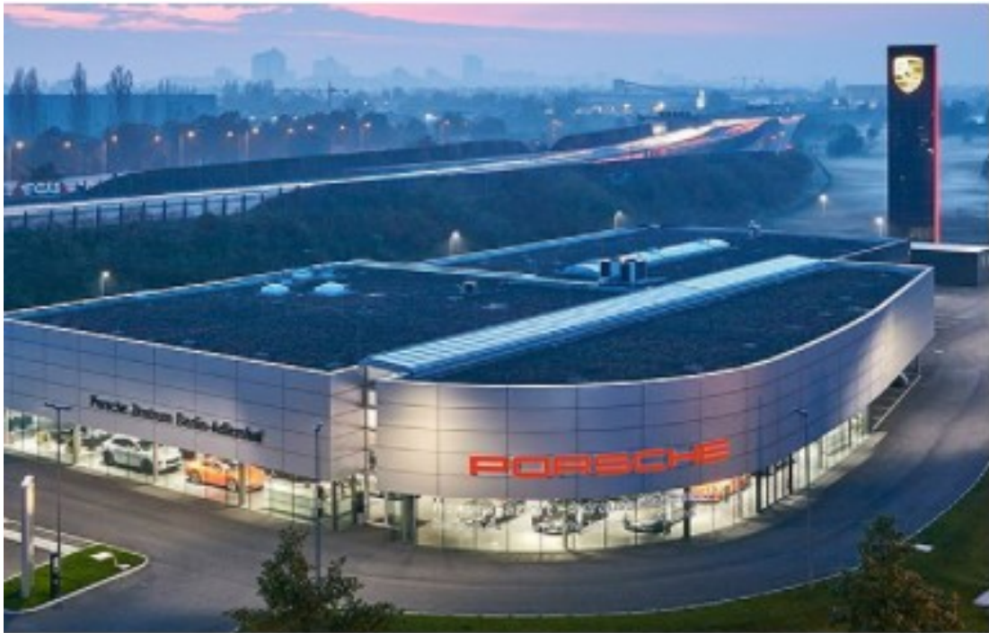
Kuva 31. Porsche-aurinkosähkötorni, joka tuottaa sähkön kiinteistöön ja asiakkaiden autojen lataukseen [47].
