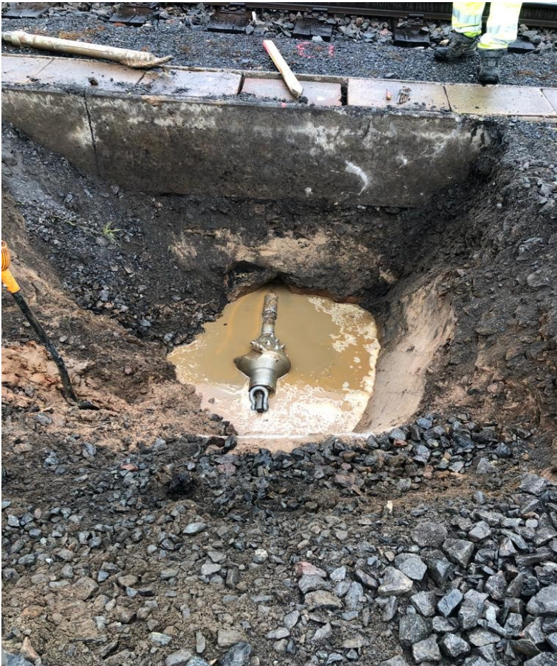
KUVA 16. Avarrin asennettuna porauskangen päähän, 31.10.2021
