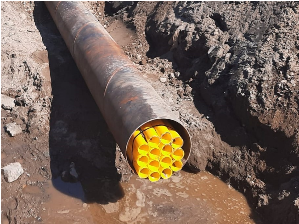
KUVA 14. Muoviputkisto asennettuna teräsputken sisään, 31.10.2021
