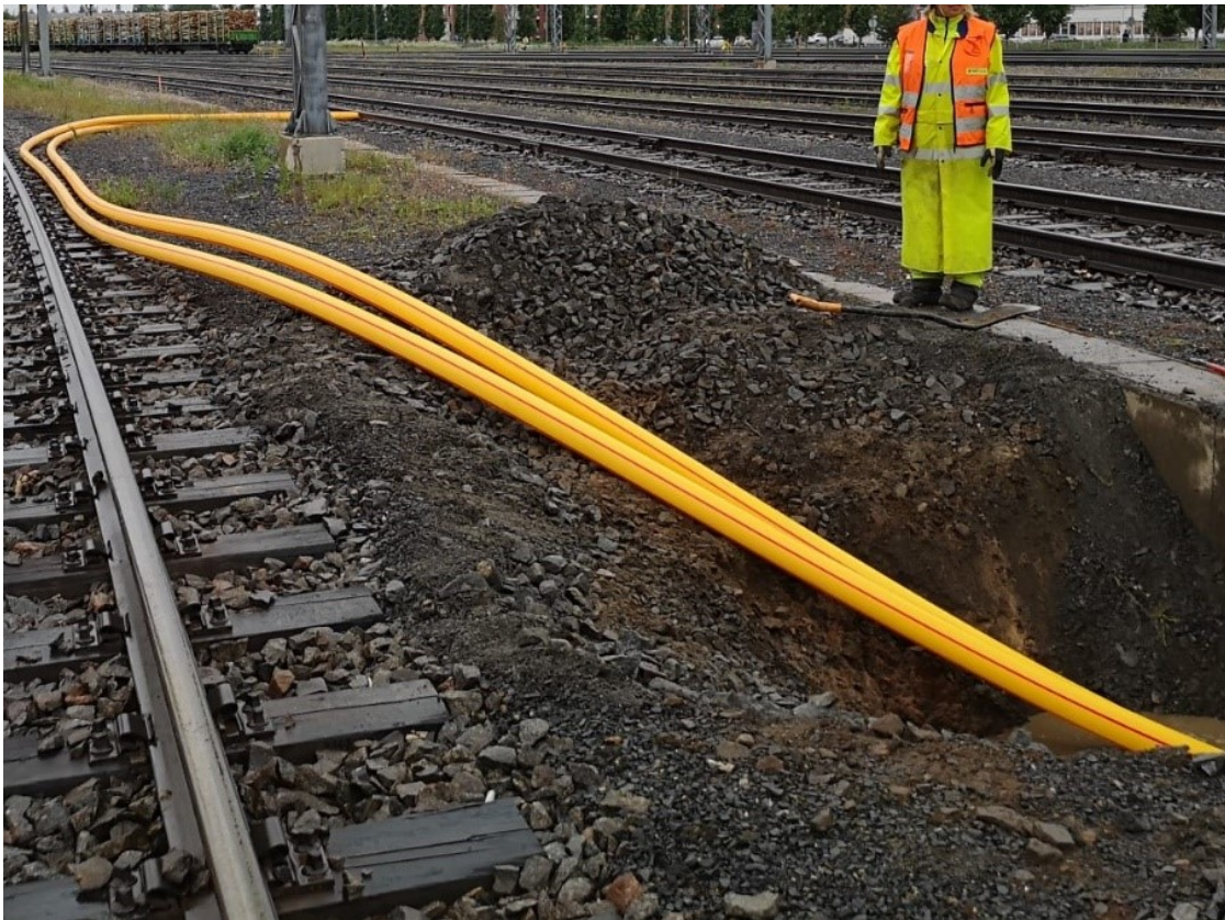
KUVA 17. Suuntaporauksessa käytettävät putket levitettynä raiteiden väliin.
