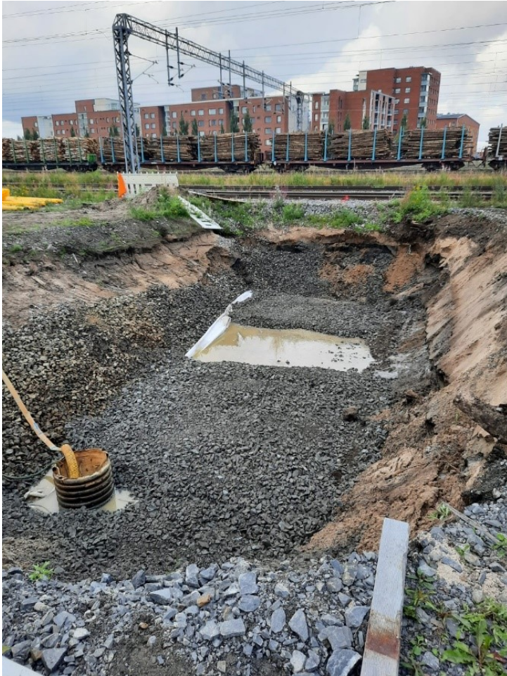
KUVA 9. Vasaraporauslaitteistoa varten rakennettu arina, 30.10.2021
