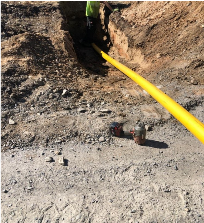
KUVA 6. Muovista valmistettu alitusputki asennettuna myyräyskärkeen, 30.10.2021
