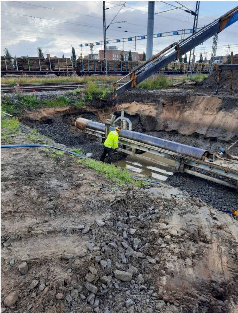
KUVA 12. Ensimmäisen putken kohdistamista porauslaitteistoon, 30.10.2021
