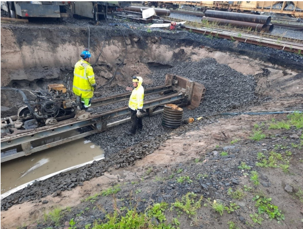
KUVA 11. Vasaraporauslaitteiston vastapenger valmiina, 31.10.2021
