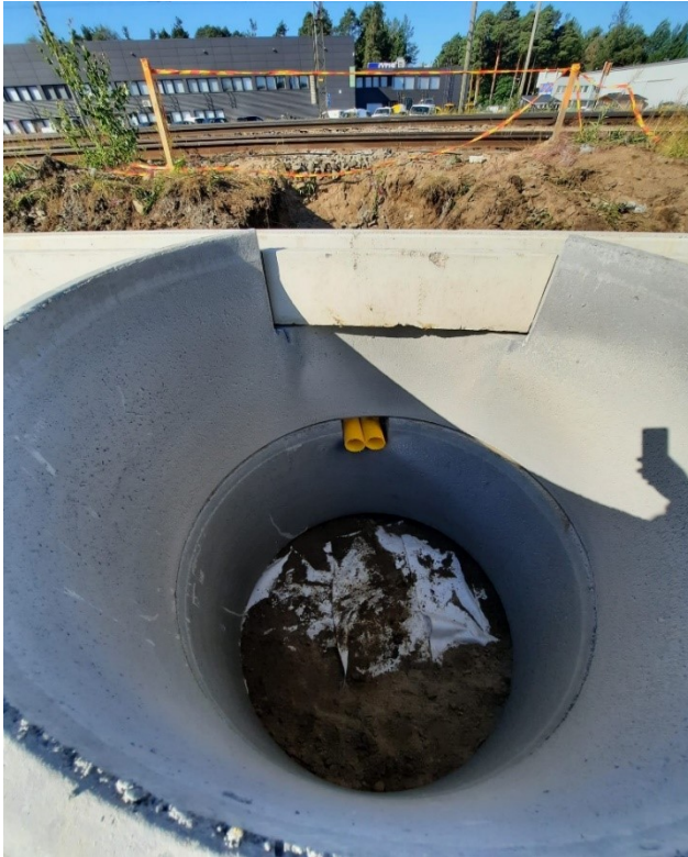
KUVA 8. D110 alitusputkia liitettyinä betoniseen kaapelikaivoon, 30.10.2021
