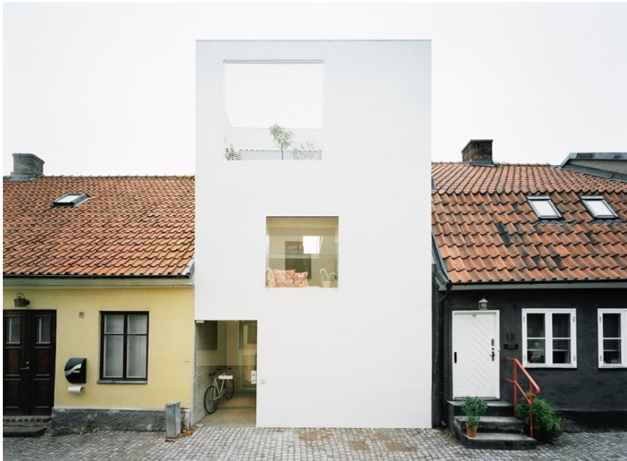
Kuva 43. Townhouse, Osacarson, Landskrona, Ruotsi, 2009. Rakennuksen kadunpuoleinen julkisivu. Ylimmässä kerroksessa on kattoterassi.
