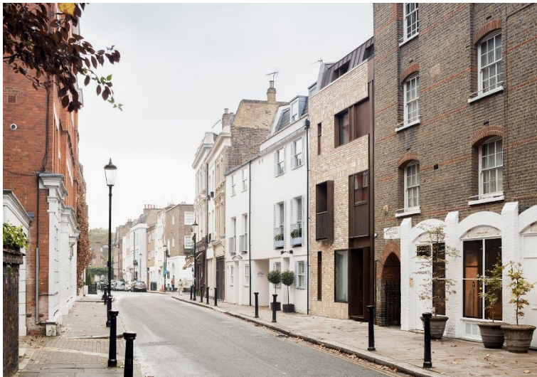
Kuva 53. Old Church Street Townhouse, TDO Architecture, 2014. Asunnosta astutaan suoraan katutilaan.
