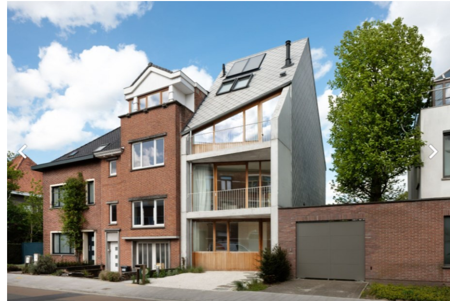
Kuva 39. House VP-VA, Graux & Baeuens, Sint-Amansberg, Belgia, 2017. Parvekevyöhyke luo suojaisan välittävän vyöhykkeen ennen asuntoon avautuvia suuria ikkunoita.
