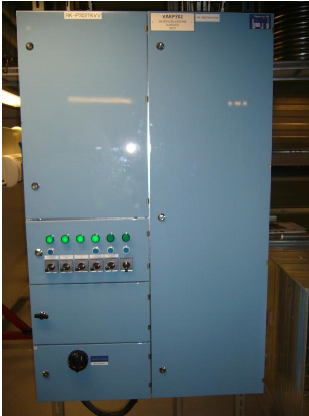
Kuvio 2. Valvonta-alakeskuskaappi Seinäjoen keskussairaalassa
