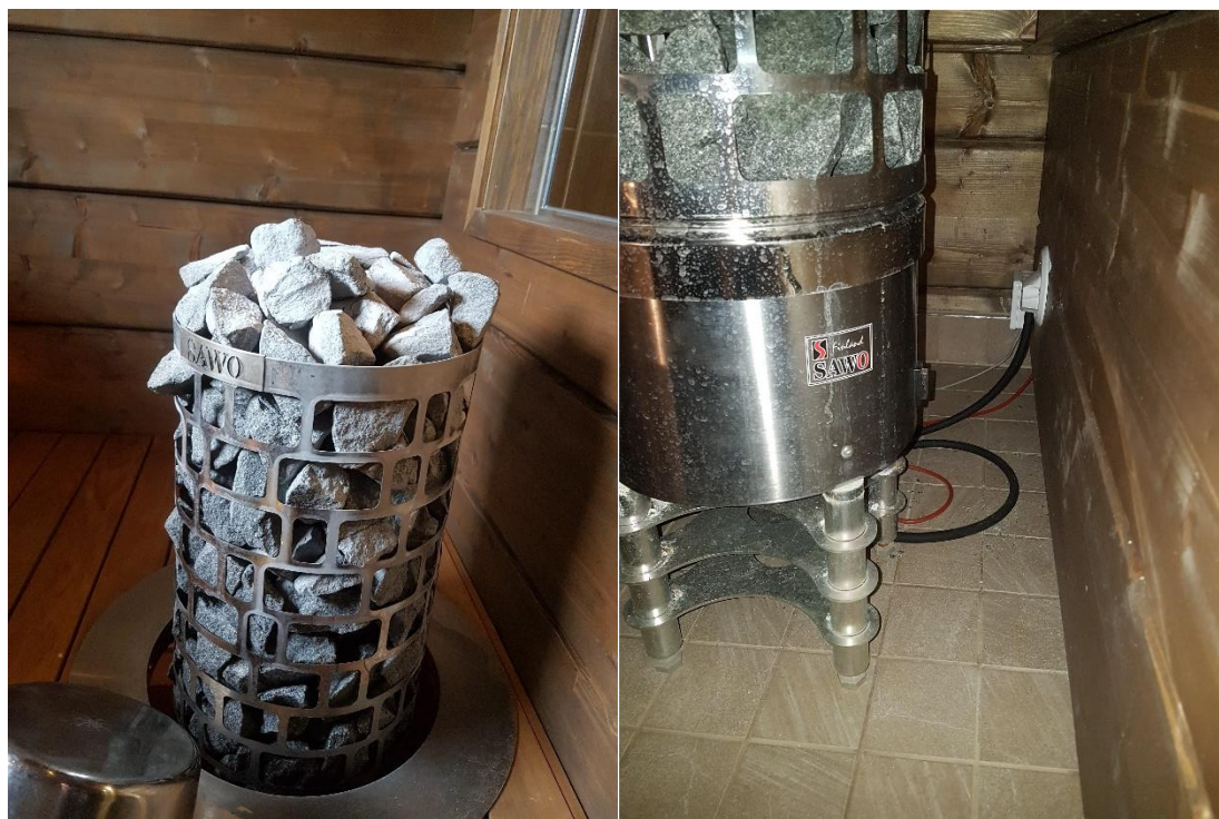
Kuva 15 Kiukaan kytkentärasia
