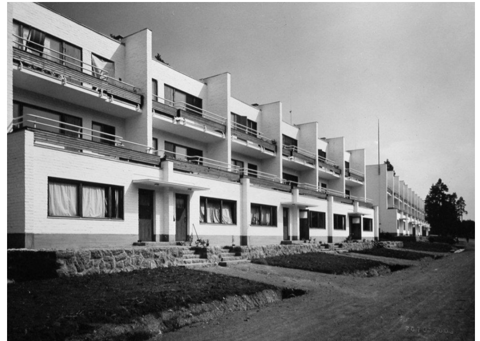
Kuva 16. Aallon Kotkan Sunilaan suunnitteleman talotyypin ROT:n runkorakenteena on käytetty paikallavalettua betonirakennetta.
