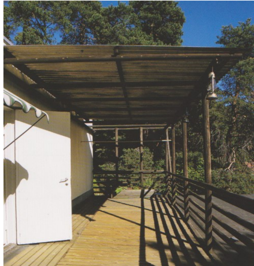
Kuva 19. Aallon Kauttuan porrastalossa kattoterassia on jäsennetty puurakenteilla.
