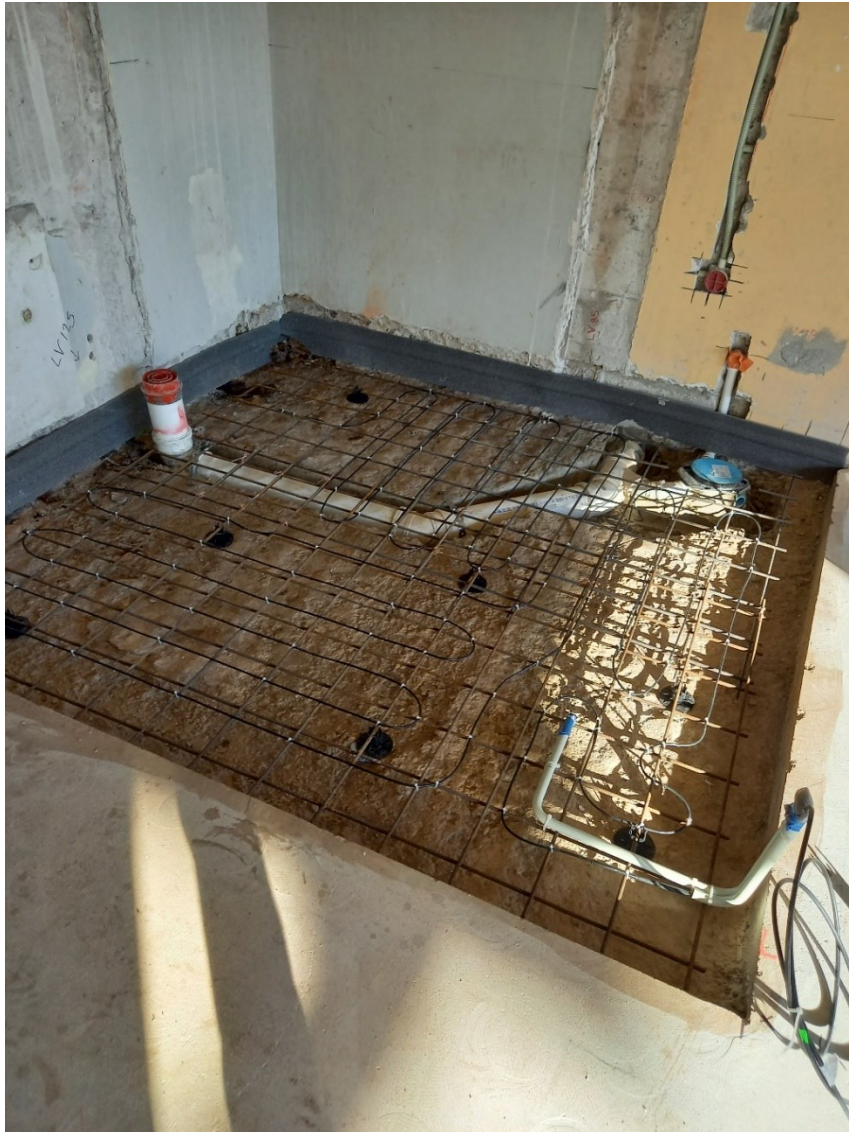
Kuva 10. WC-tilan lattia ennen betonivalua.
