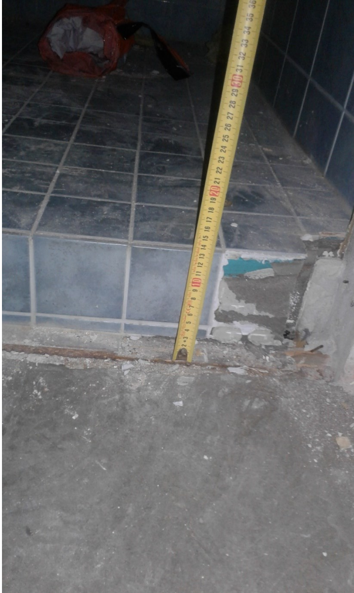
Kuva 9. Vanhan märkätilan lattia ennen purkua suhteessa ympäröivään lattiapintaan.
