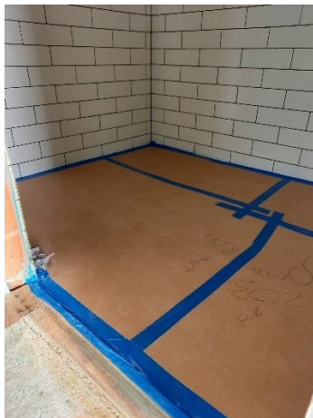
Kuva 17. Suojattu märkätilan lattia.
