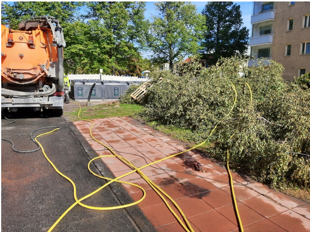
Liite 1. Kuva 6. AsOy Sammonkartano, kollektoriputkien huuhtelua
