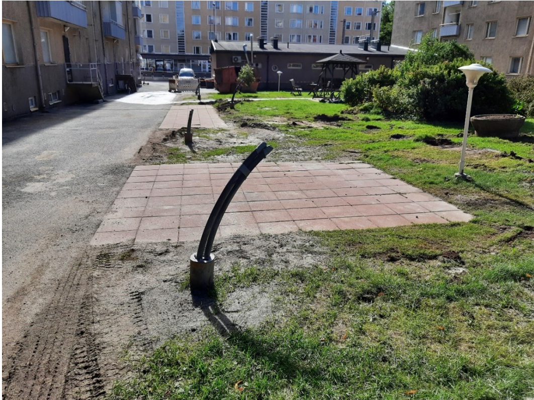
Liite 1. Kuva 5. AsOy Sammonkartano, valmiita energiakaivoja kollektoriputkineen
