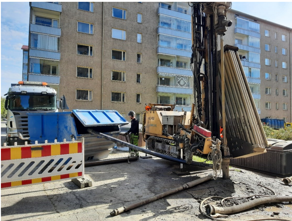
Liite 1. Kuva 2. AsOy Sammonkartano, energiakaivoporauskalusto
