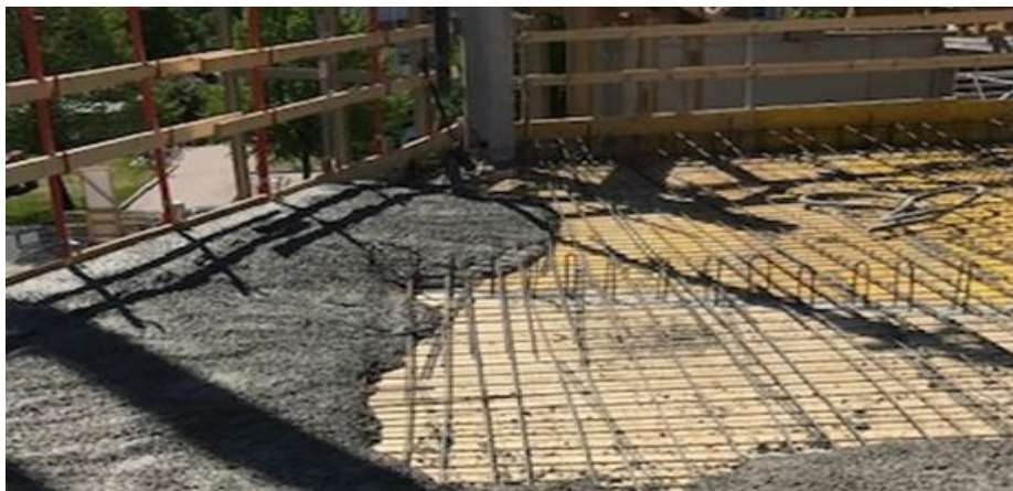
KUVA 13. Välipohjan betonointi (Ruuskanen 2021)
