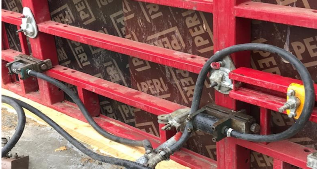
KUVA 14. Muotin ulkopuoliset täryttimet (Ruuskanen 2021)
