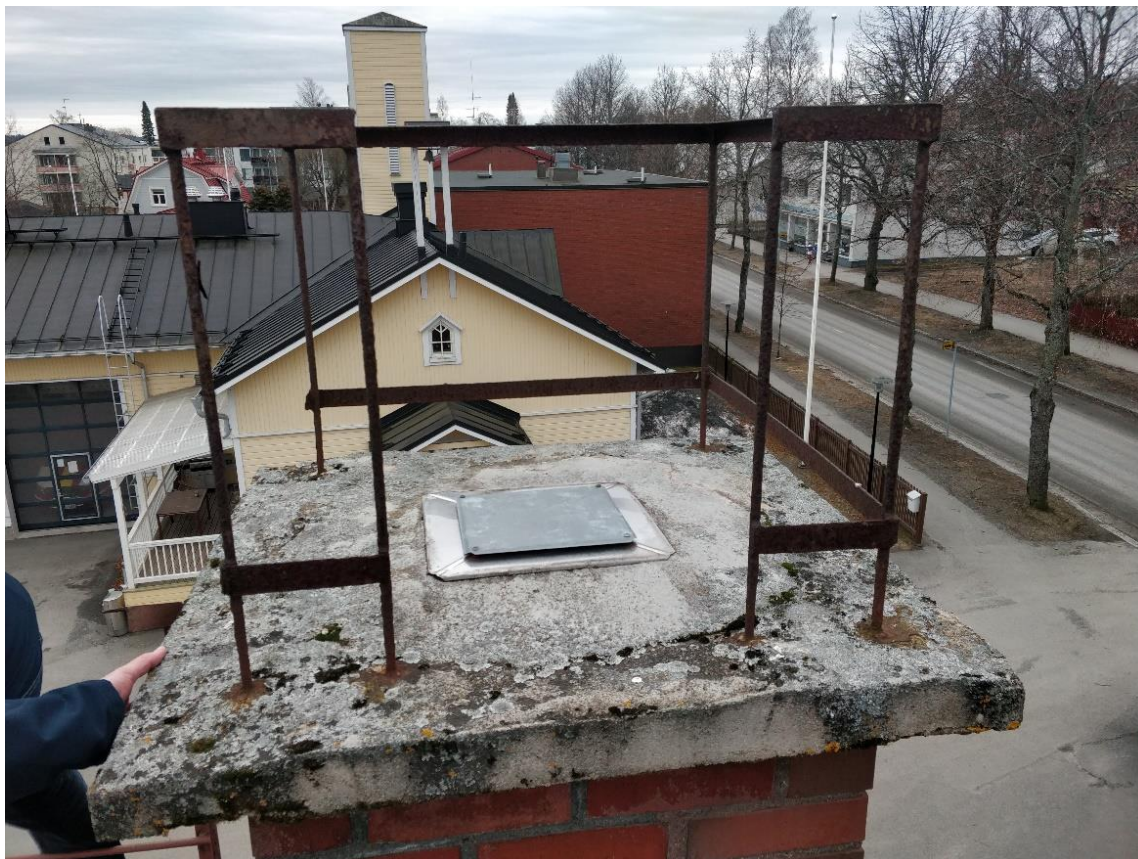
KUVA 10. Talon seinustan hormin yläpää (Tynkkynen 2020, CC BY-SA)
