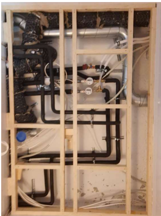
Kuva 12. Kylpyhuoneen alakaton yläpuolelle piiloon jäävät viemäri- ja vesijohtohajotukset eristettynä.
