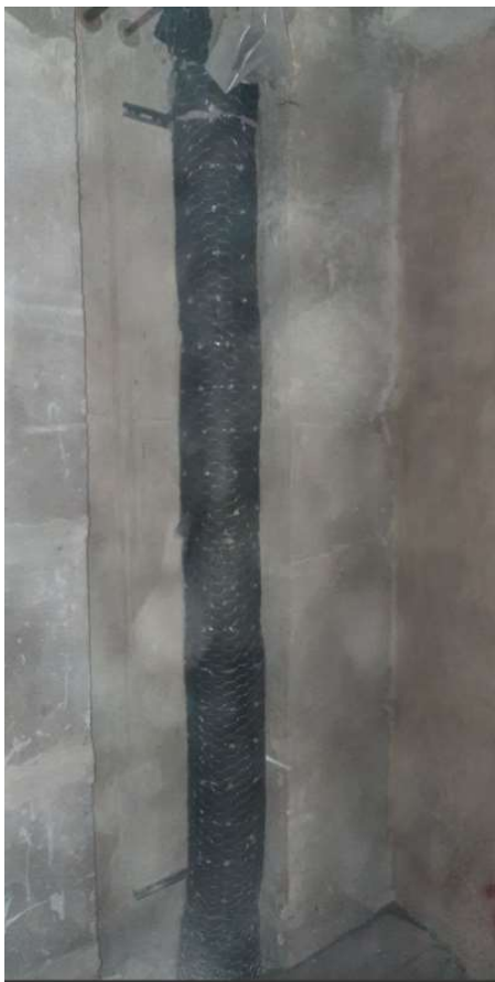
Kuva 10. Uusi viemärinousu kylpyhuoneen vanhassa hormissa.
