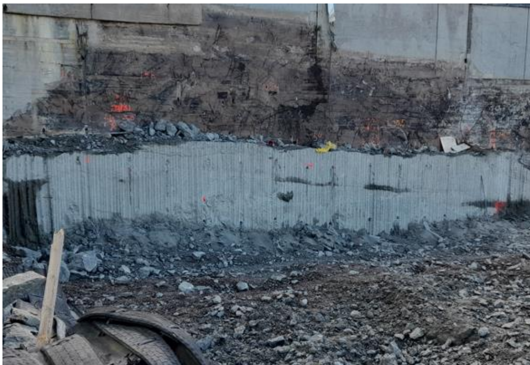
Kuva 19. Irtiporauslinja louhintatyömaan ja sairaalan vanhan osan välissä.
