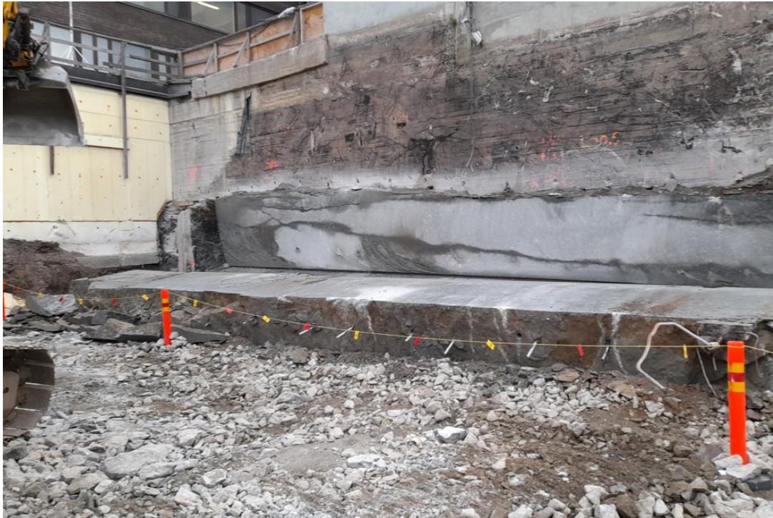
Kuva 21. Kaadettu kiviseinä vajerisahausten jälkeen.
