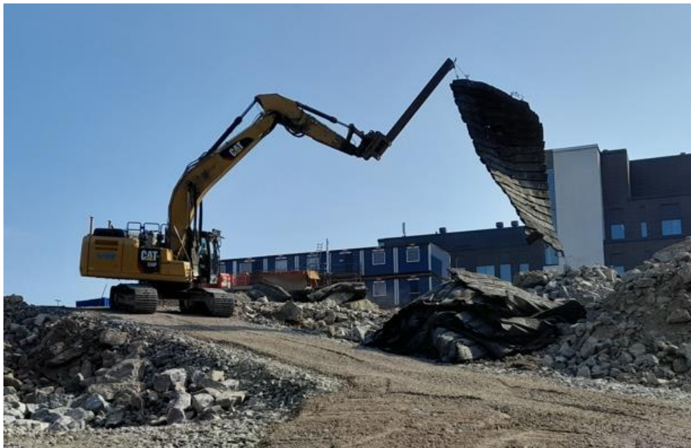
Kuva 7. Kumimattojen pinoamista tutkimuksen kohteena olevalla työmaalla.
